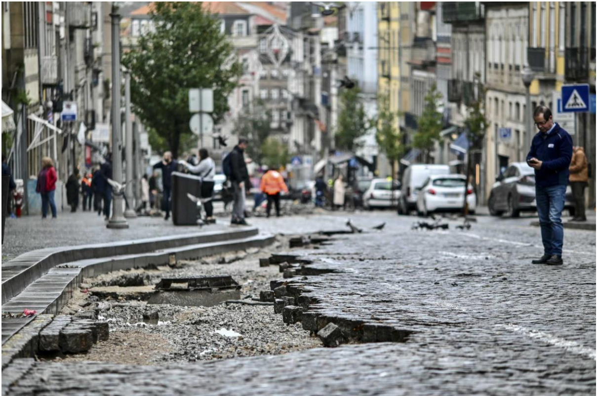
Figura 2- Alagamentos em ruas e áreas urbanas
