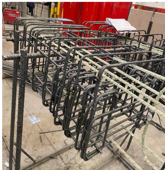
Figure 3.7.1 Ensamblaje de las armaduras antes de colocarlas en el molde
