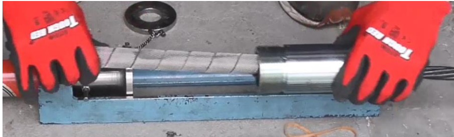
Figura 3.4.1.2 Manguito de conexión y su montaje
