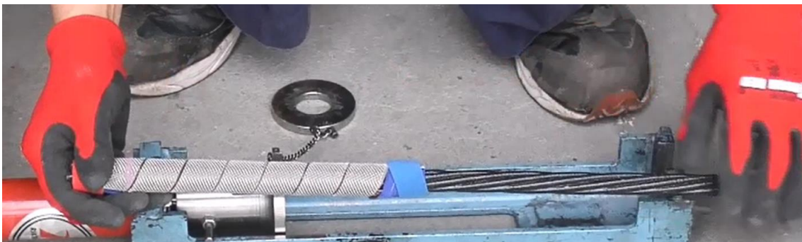
Figura 3.4.1.1 Material de amortiguación para el tesado y su montaje
