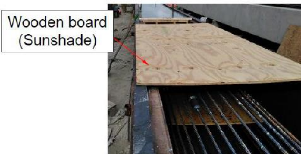
Figura 3.4.1.8 Recomendación de protección de los sistemas durante el tesado
