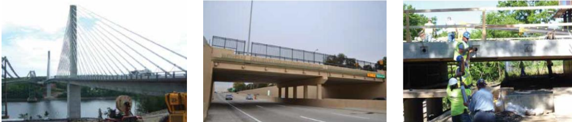
Figura 2.5.1.1 Penobscot Narrow Bridge / Pembroke Bridge / Paso de cables CFRP en el puente de la M-50
