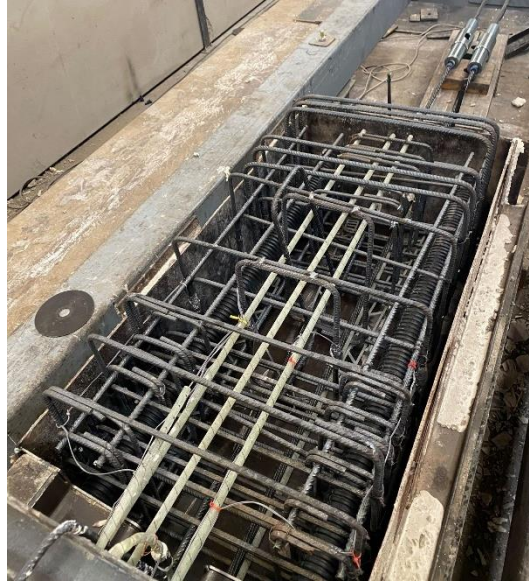
Figure 3.7.2 Colocación de las armaduras activas y pasivas y las vinas para el postensado de continuidad
