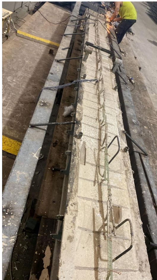
Figura 3.7.5 Imagen después de relajar los gatos y cortando el sobrante de los cables CFCC
