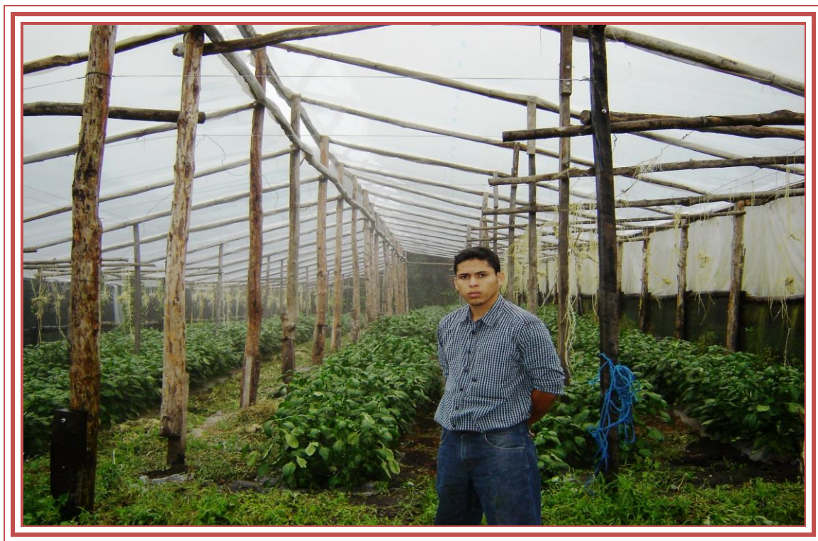
FIGURA 14: ESTRUCTURA DE UN INVERNADERO TIPO RÚSTICO, PROPIETARIO INGENIERO JUAN GONZÁLEZ, DISTRITO DE BOQUETE.
