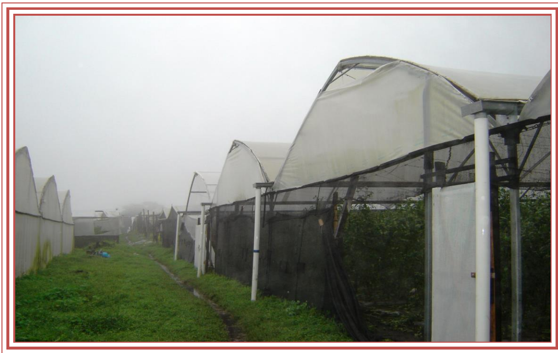
FIGURA 16: ESTRUCTURA DE UN INVERNADERO TIPO TECNIFICADO, PROPIETARIO ING. JUAN GONZÁLEZ, BOQUETE.
