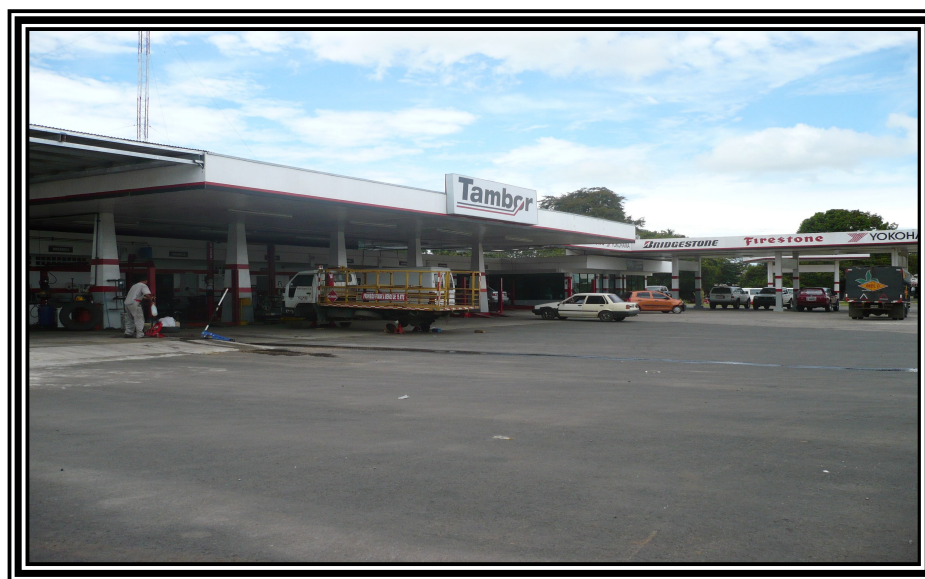
Figura N° 1: Vista de las instalaciones del taller TAMBOR, S.A., Sucursal de David.
