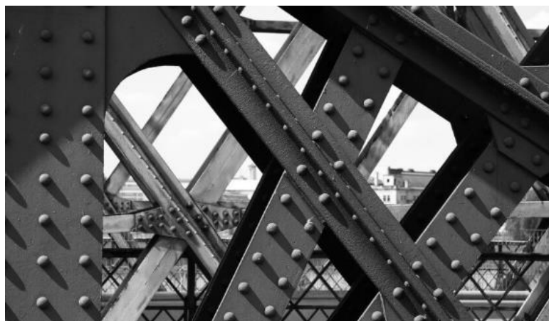
Obrázek 20: Nýtování mostové konstrukce [17]
