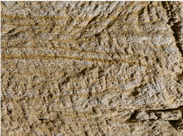
8 Schlegel und Eisen Spuren am anstehenden Gestein des »Langen Kellers« (Foto: Peter Suhr)
