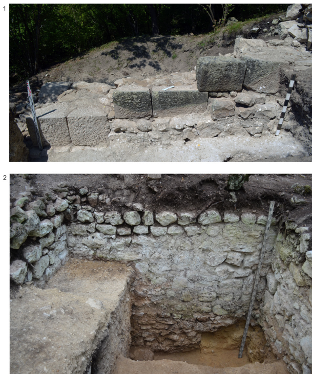
Ил. 3. 1 – Облицовка тыльного панциря укрепления в Каралезской долине (фото В. Е. Науменко). 2 – Облицовка тыльного панциря стены башни № 1 укрепления Сиваг-Кермен (фото В. Е. Науменко)
