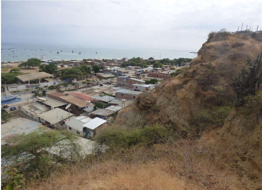
Fotografía 24. A.H. Francisco Pizarro, al pie del talud, propenso a derrumbes y caída de rocas debido a procesos de erosión de ladera, distrito de Zorritos. Coordenadas UTM: 536150 / 9593128, Zona 17. Tomado el 25/08/2023.
