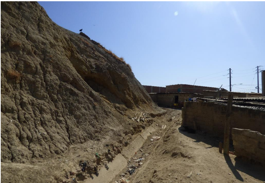
Fotografía 27. Torrenteras a través de viviendas provenientes de la erosión de ladera en el Barrio Marcos Herrera, distrito de Canoas de Punta Sal.
