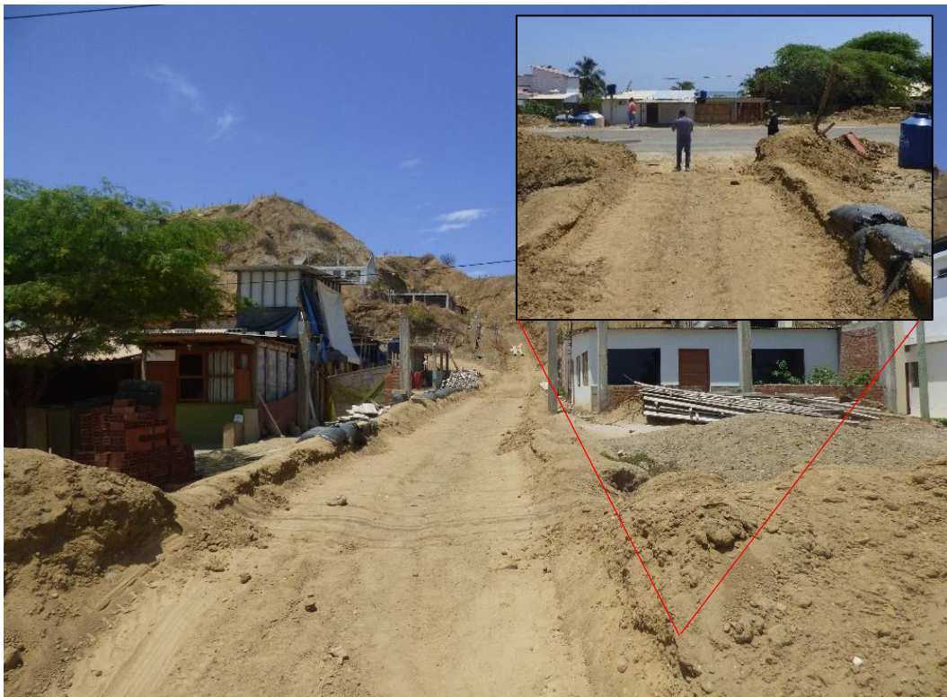
Figura 32. Flujo de lodo que discurren entre las viviendas, encauzada con sacos de arena. Aguas abajo afecta vía Panamericana Norte en un tramo de 50 m., sector Bonanza, distrito de Zorritos. Coordenadas UTM: 527174 / 9588760, Zona 17. Tomado el 25/08/2023.
