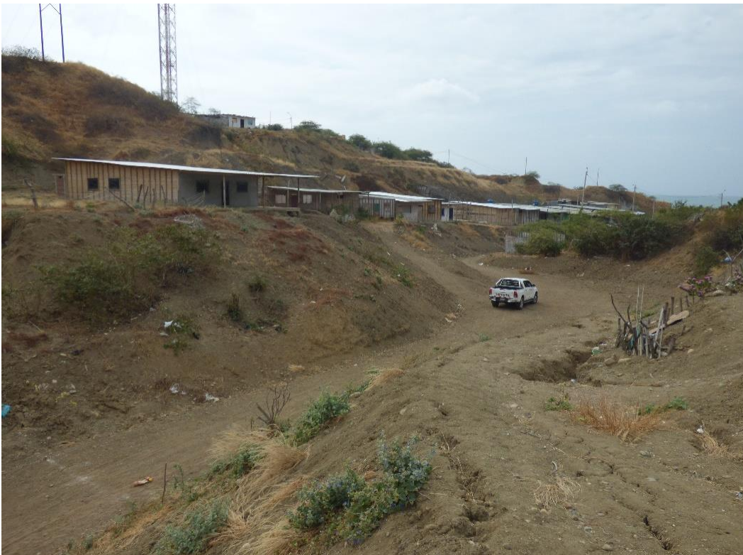
Fotografía 20. A.H. Los Ángeles, distrito de La Cruz. Se aprecian viviendas sobre depósito de relleno afectadas por erosión de laderas en las márgenes de la quebrada Bancharo Rossi. Coordenadas UTM: 544833 / 9597412, Zona 17. Tomado el 22/08/2023.
