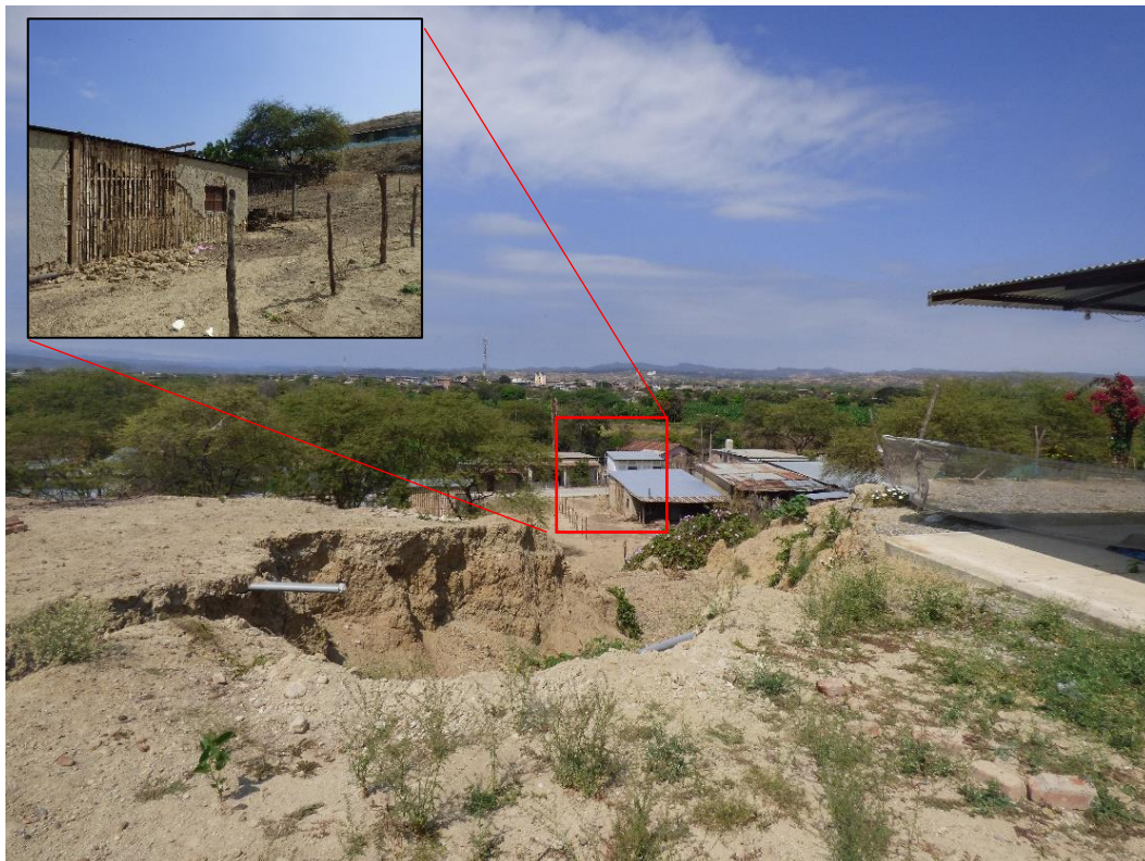
Figura 26. Flujo de lodo y detritos originado por erosión de laderas, afectando viviendas aguas abajo, centro poblado Cardalitos, Pampas de Hospital. Coordenadas UTM: 562842 / 9592441, Zona 17. Tomado el 24/08/2023.
