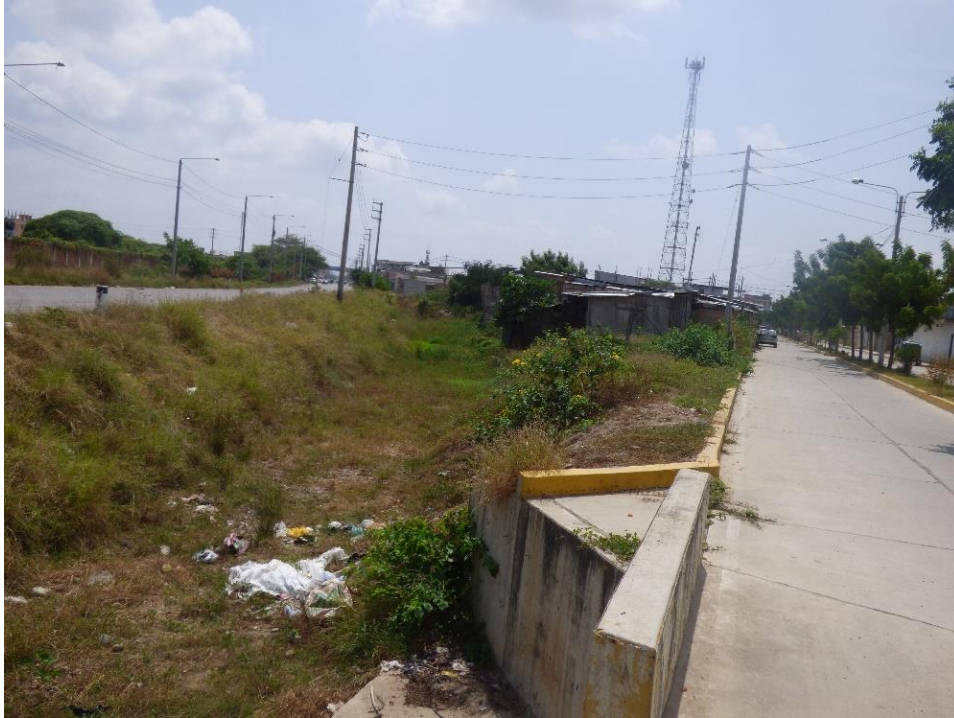
Fotografía 4. Vista de quebrada La Rocana, colmatada aguas abajo. Hacia la margen izquierda vía Panamericana Norte y hacia la margen derecha vía de acceso al distrito de Zarumilla y viviendas. Sector Pampa de Los Venados.
