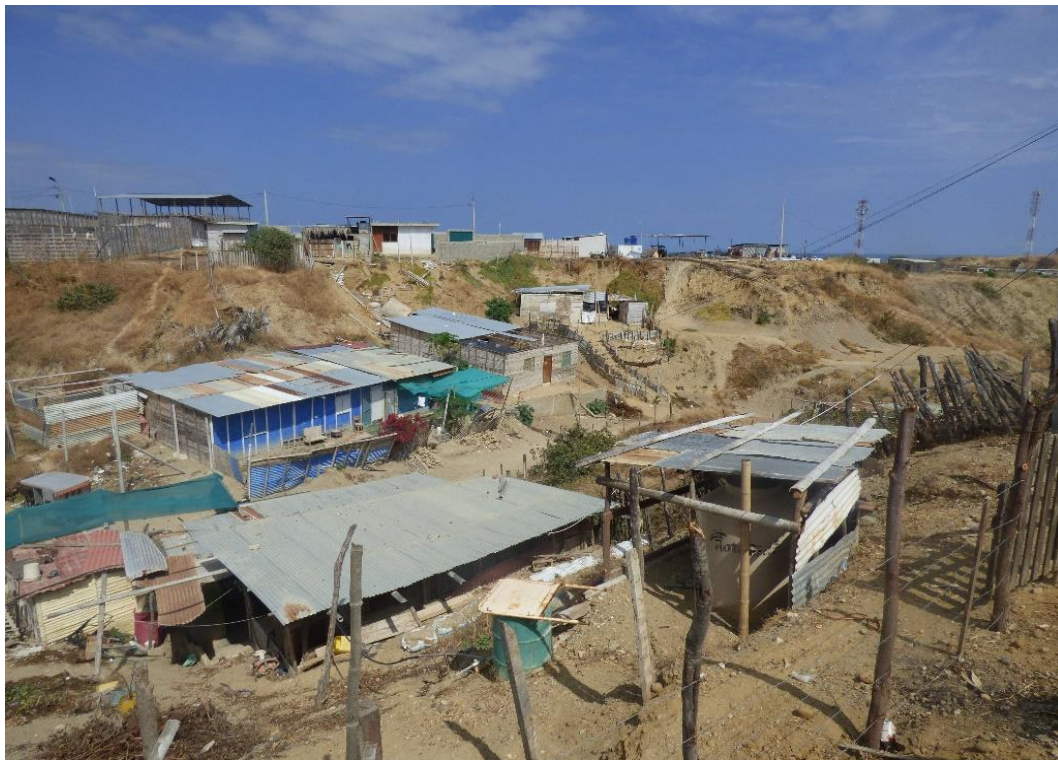
Fotografía 22. Quebrada Leoncio Prado, se observa viviendas dentro del cauce de la quebrada, así como también en las márgenes, asentadas sobre depósitos de relleno. Coordenadas UTM: 535481 / 9592756, Zona 17. Tomado el 25/08/2023.
