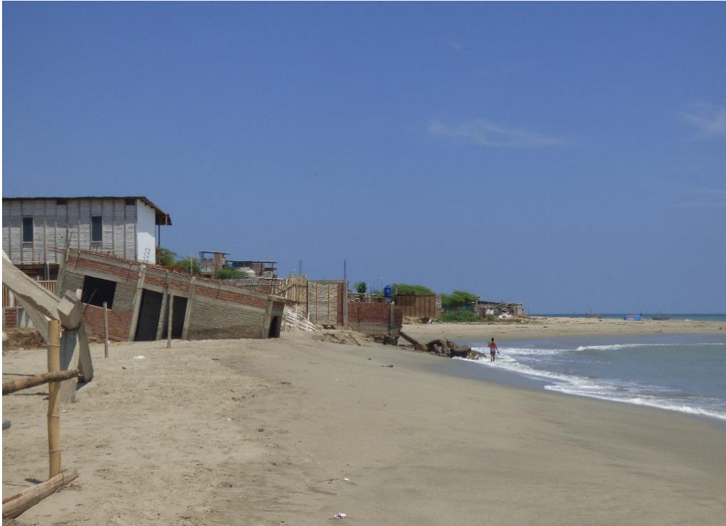
Fotografía 23. Viviendas afectadas por procesos de erosión marina en el sector Costa Verde, distrito de Zorritos.
