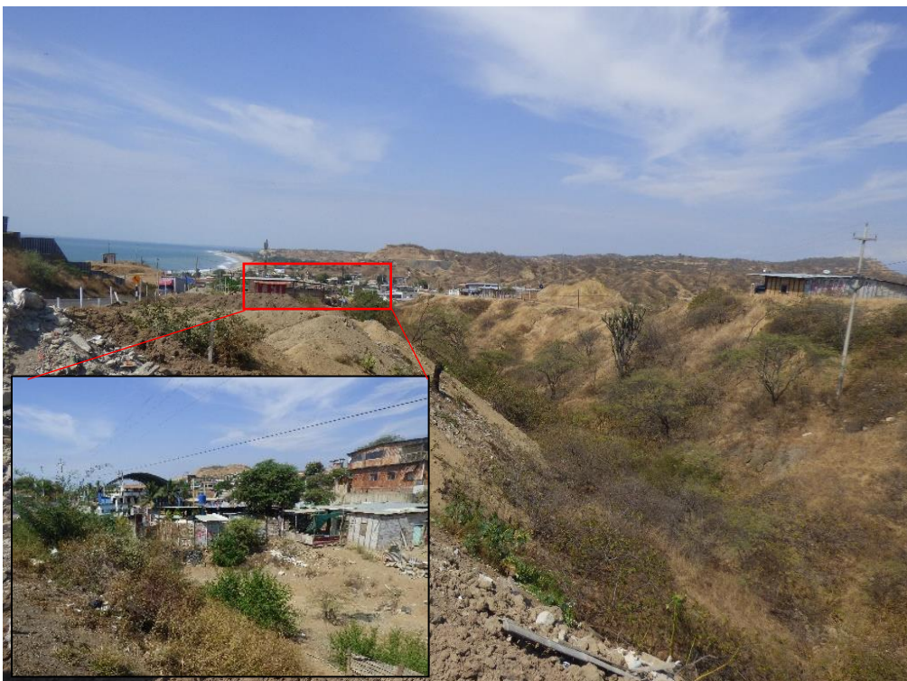
Figura 30. Vista aguas debajo de quebrada Grau colmatada con desmote y basura. En las márgenes se tienen nuevos asentamientos humanos. Aguas abajo, se presenta viviendas dentro del cauce, sector Caleta Grau. Coordenadas UTM: 558272 / 9594367, Zona 17. Tomado el 25/08/2023.
