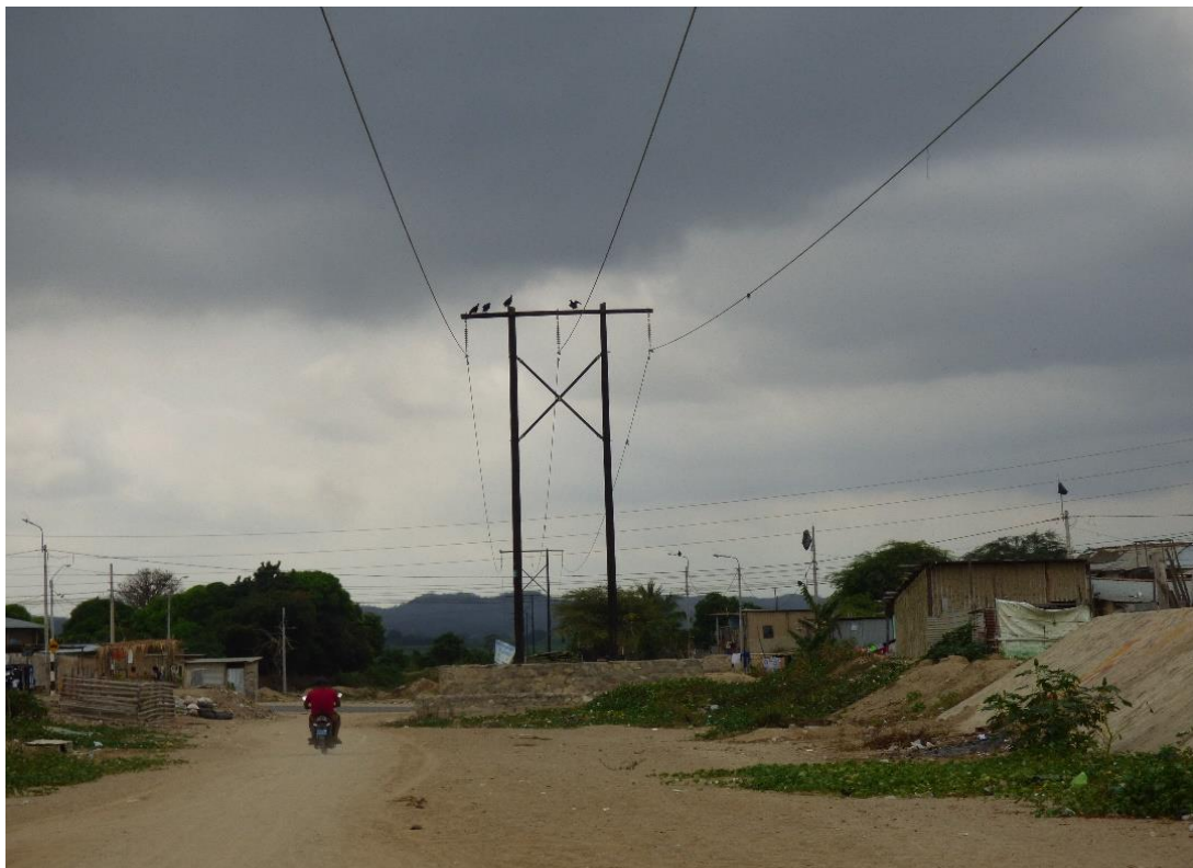
Fotografía 11. Vista aguas abajo de la quebrada Malval, Corrales. Se observa un poste de cableado eléctrico en el cauce de la quebrada, además de viviendas hacia los márgenes. Coordenadas UTM: 558733 / 9599848, Zona 17. Tomado el 23/08/2023.
