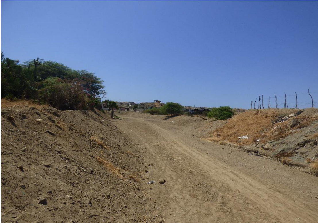
Fotografía 28. Quebrada Nuevo Cancas, distrito de Canoas de Punta Sal, con arrimado de material como defensa ribereña.
