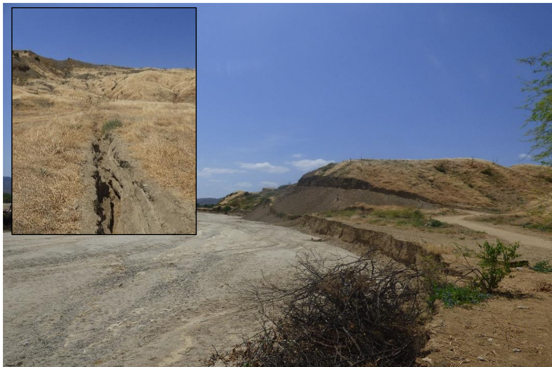
Figura 35. Flujo de detritos colapsó vía vecinal, además de inundar cultivos y viviendas. Hacia las zonas altas se observan erosión en cárcavas de casi 2m. de profundidad en el centro poblado Pajaritos, distrito de Canoas de Punta Sal.
