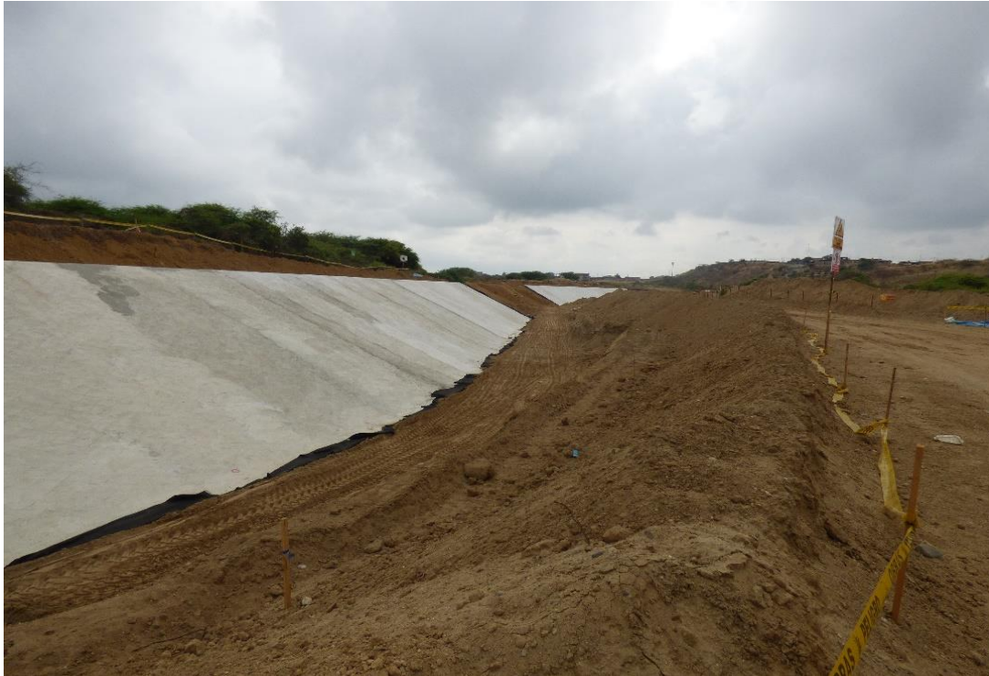
Fotografía 10. Obras de canalización en ambas márgenes de la quebrada Corrales. Coordenadas UTM: 556460 / 9599352, Zona 17. Tomado el 23/08/2023.
