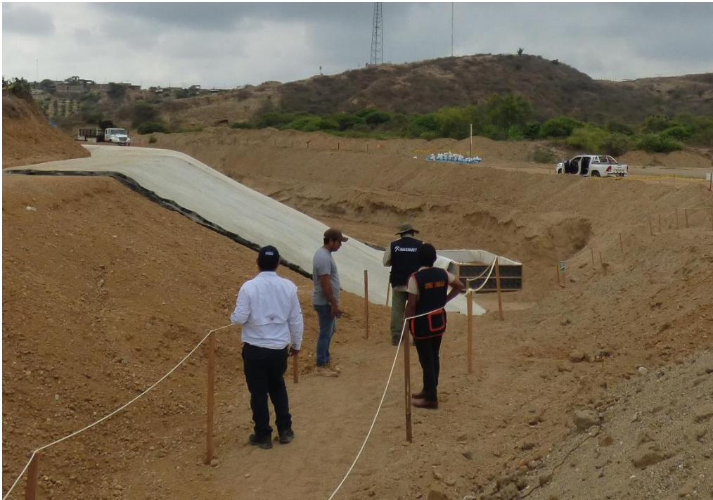
Fotografía 35. Visita con representantes de Indeci del distrito de Corrales a la quebrada del mismo nombre, donde se tiene obras de encauzamiento en ejecución.
