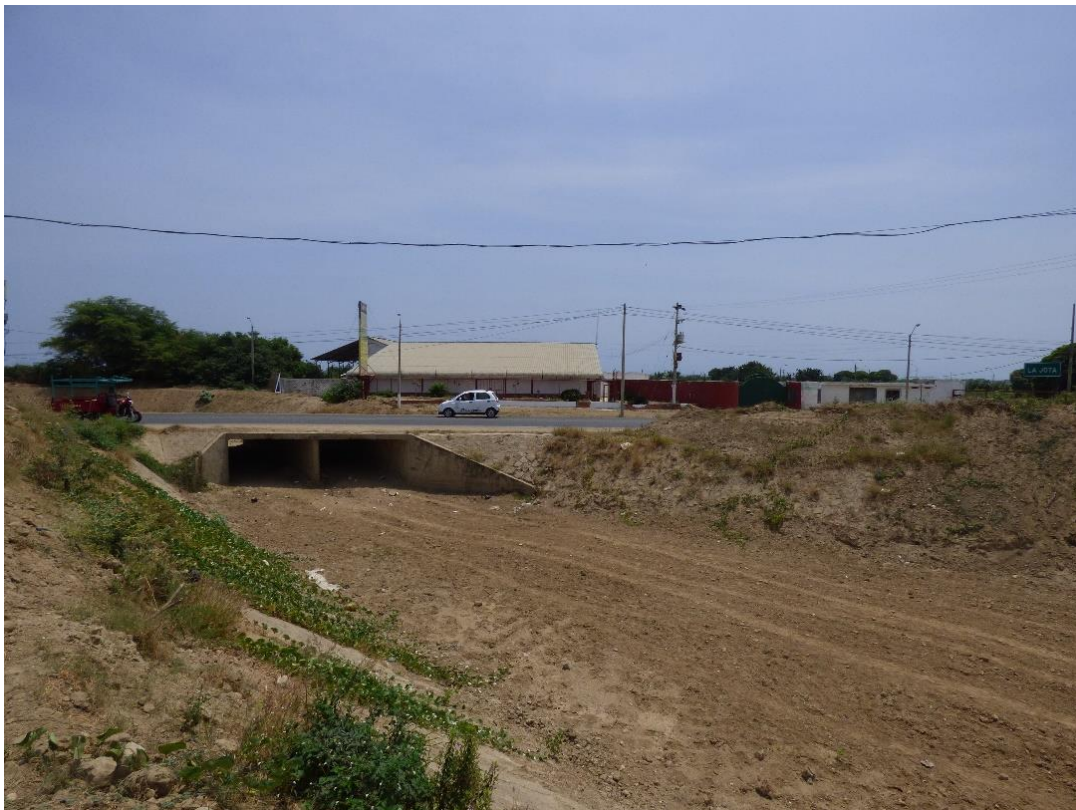
Fotografía 13. Quebrada estrechándose por alcantarilla en su paso por la vía Panamericana Norte, C.P. La Jota, distrito de Corrales. Se observa canalización por arrimado de material.
