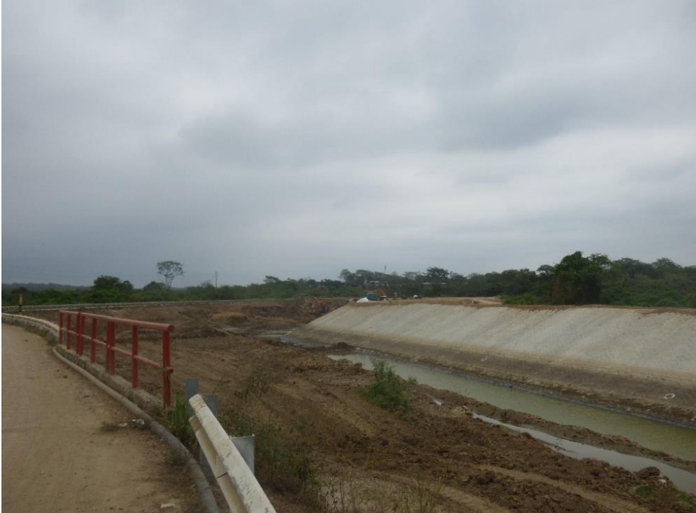
Fotografía 6. Obras de canalización, en zona de confluencia de quebradas, vía Zarumilla – Papayal – Matapalo, km 11.
