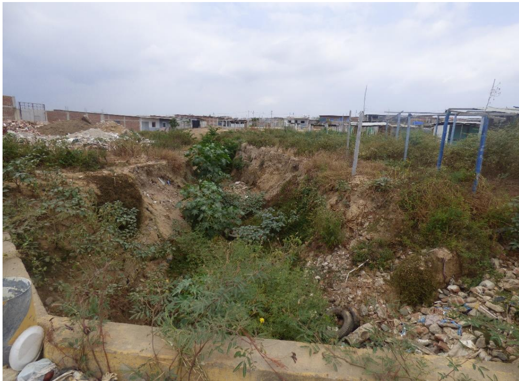
Fotografía 9. Quebrada activada durante el ciclón Yaku en su paso por el A.H. Ciudadela Noé, Tumbes. El cauce se encuentra bloqueado por múltiples viviendas, al igual que las márgenes.
