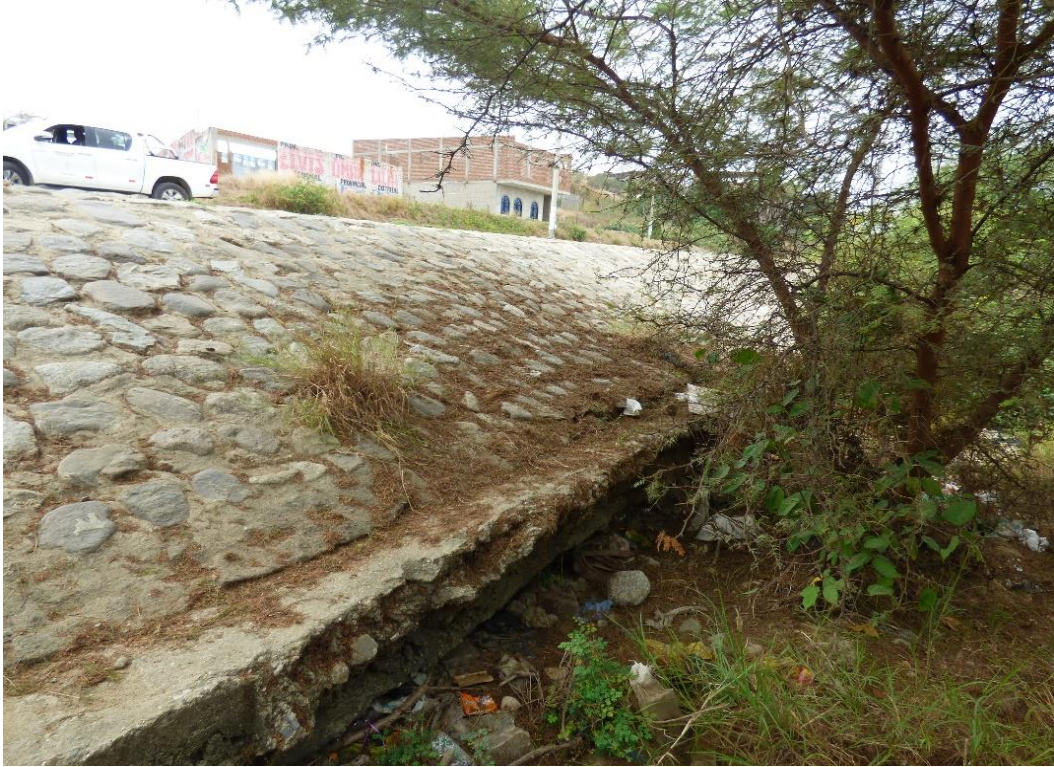
Fotografía 14. Baden que presenta erosión retrogresiva en las bases por acción de flujos de lodo y detritos en la vía Tumbes – San Juan de La Virgen – Pampas de Hospital, centro poblado Garbanzal.
