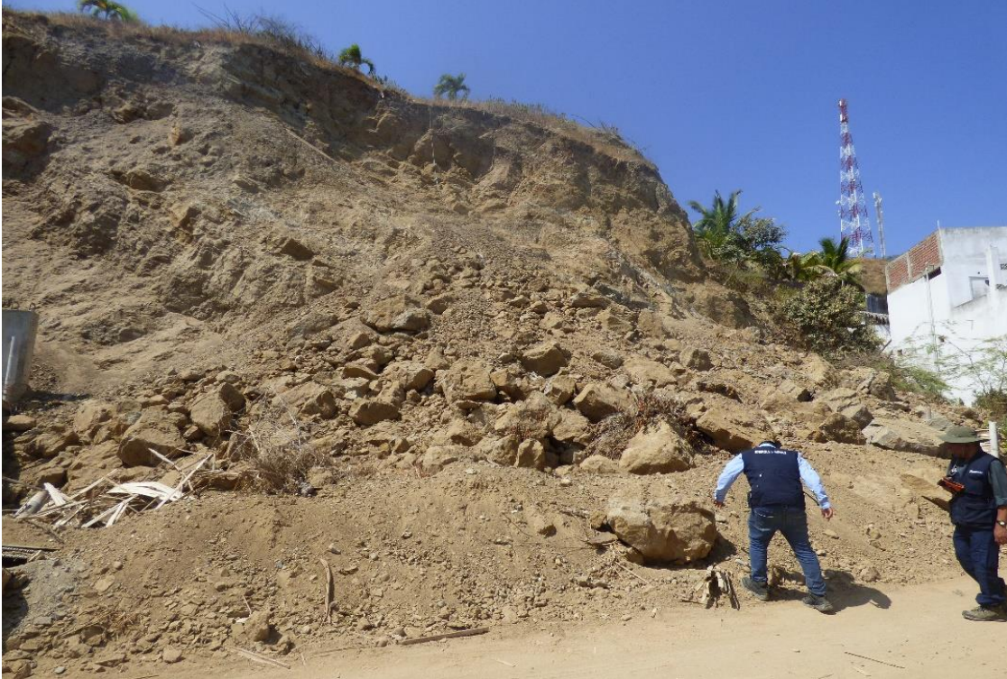
Fotografía 29. Derrumbe en el sector Punta Sal Grande, afectando viviendas y vías de acceso al balneario.
