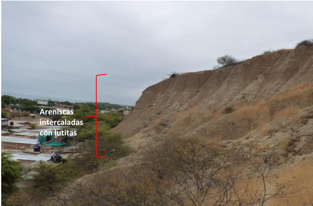
Figura 9. Secuencias de areniscas intercalados con niveles delgados de lutitas correspondientes a la Fm. Tumbes, afectados por procesos de erosión de laderas. Sector A. H. Las Malvinas, distrito La Cruz.
