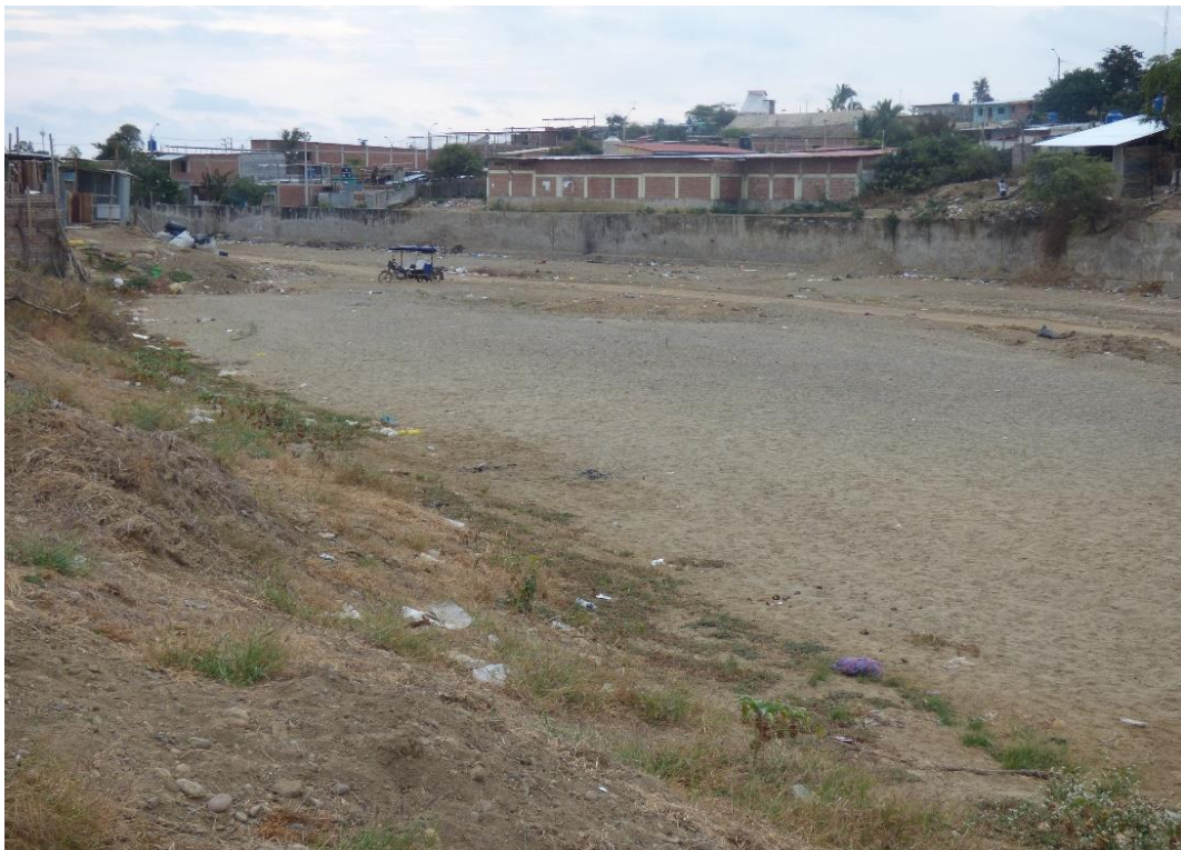
Fotografía 18. Quebrada Coloma (vista aguas abajo). Se presenta defensas ribereñas a la margen derecha, mientras que, hacia la margen izquierda, viviendas sin protección alguna, distrito La Cruz.
