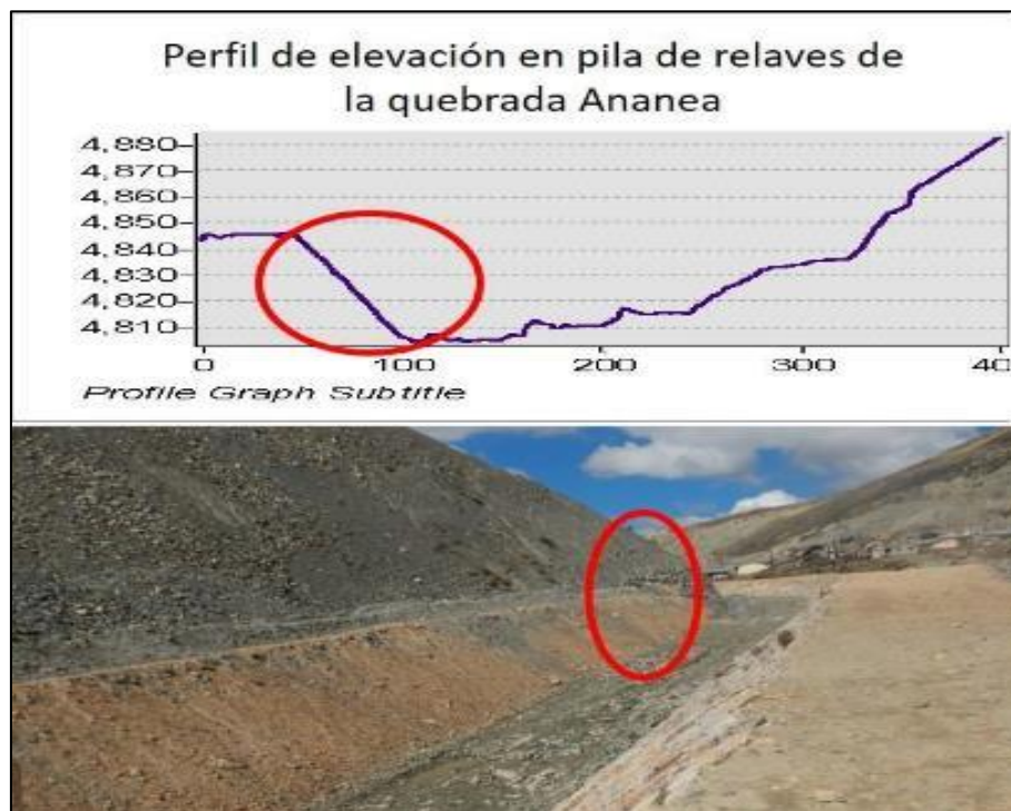
Figura 3. Aledaño al poblado se aprecia el talud, compuesto por rellenos de materiales de relaves depositados junto al canal de la quebrada Ananea, con una altura de 40 m.
