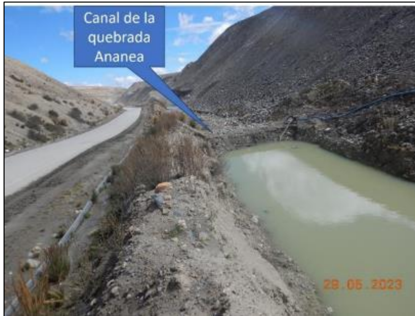
Figura 4. Se aprecia el canal principal de la quebrada Sillacunca obstruida y con material de relaves.
