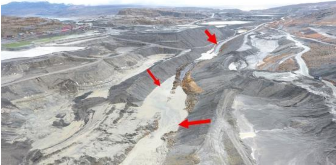
Figura 5. Fotografía tomada el día 26 de noviembre del 2021, se aprecian los deslizamientos en los depósitos de materiales de relaves ocasionados por una mala estructura de sus taludes y la infiltración de agua (Fuente: informe técnico N°019-2021-GR PUNO-ORGRDS).
