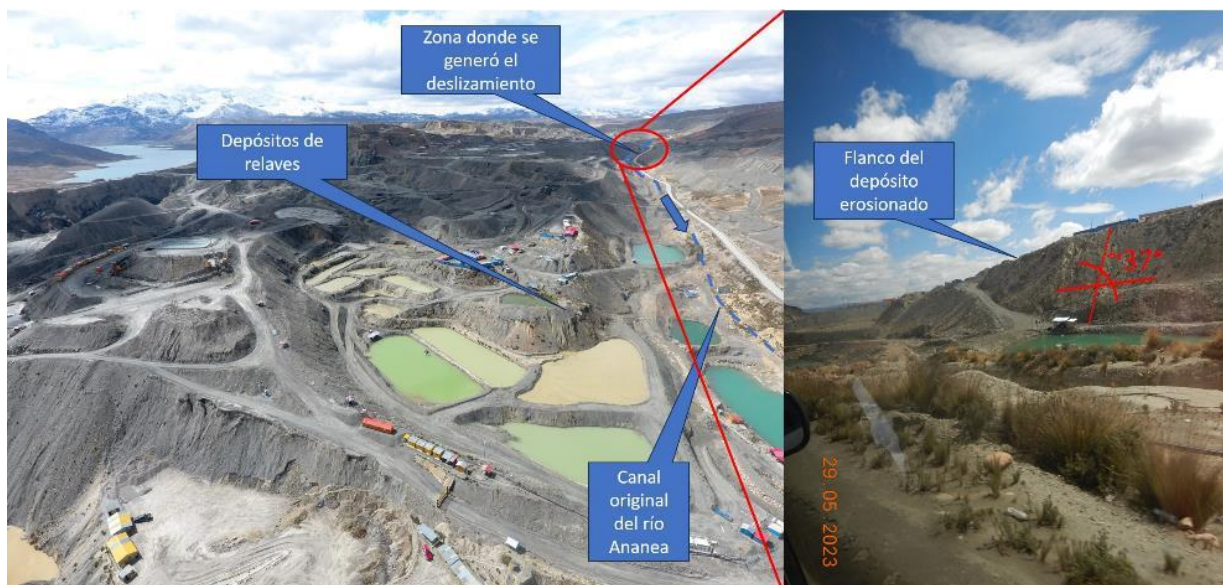
Figura 6. Foto tomada el día de la inspección, donde los deslizamientos ocurridos no son apreciables, por la reconstrucción de los taludes y de la vía Ananea – La Rinconada luego de ocurrido el evento.
