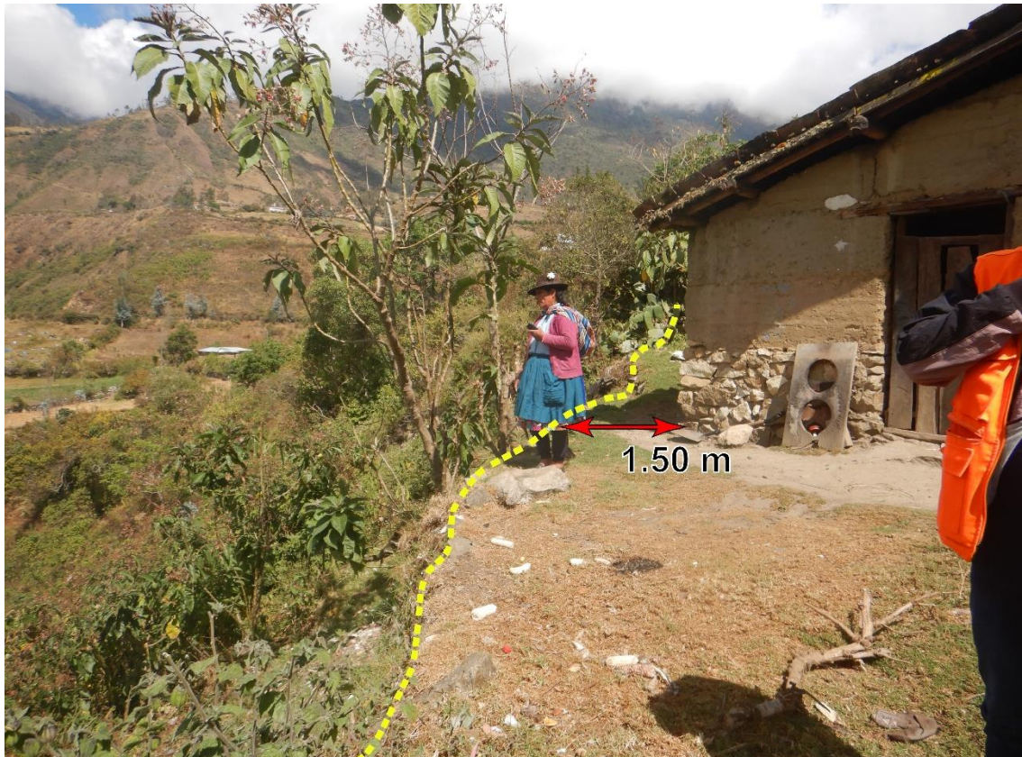
Figura 14. Vivienda ubicada al borde de la escarpa principal del deslizamiento activo DA-02 , la cual se encuentra a solo a 1.5 m.
