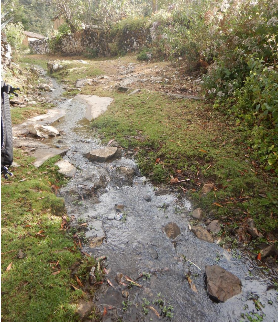
Fotografía 6. Canal de riego sin revestimiento de 1.2 m de ancho, cuyas aguas se direccionan a la cárcava activa CA-01, ubicada aguas abajo.
