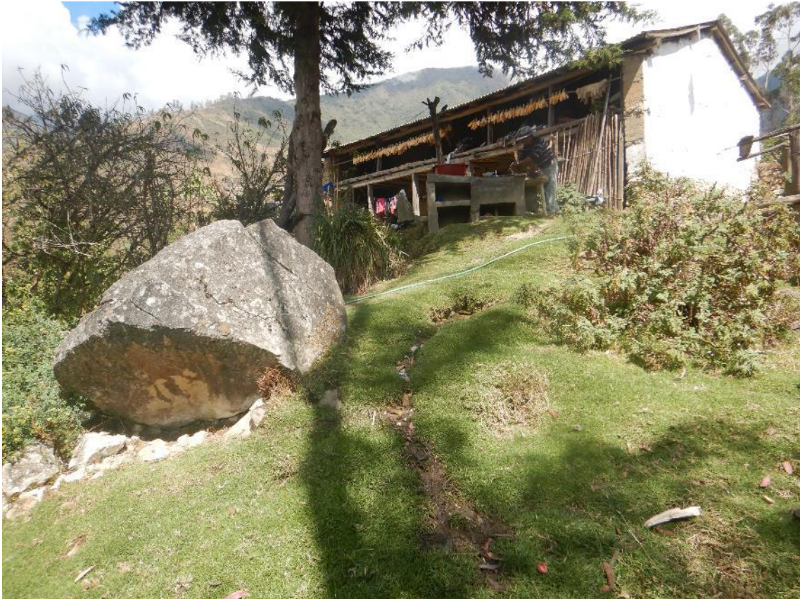
Fotografía 7. Manejo inadecuado del agua de escorrentía de viviendas del sector Millpo. Estas aguas discurren directamente a las laderas y generan mayor erosión e inestabilidad en el terreno por saturación del suelo.
