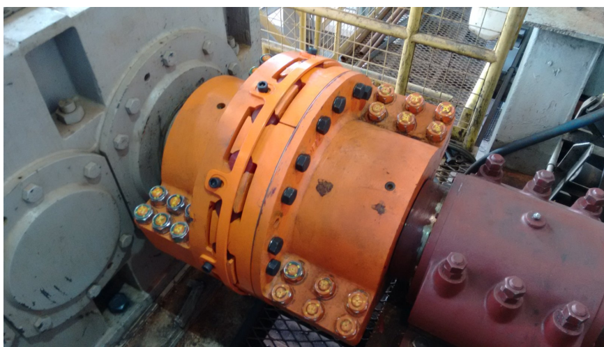
Figura 11 – Acoplamento elastomérico bipartido HDFB.
