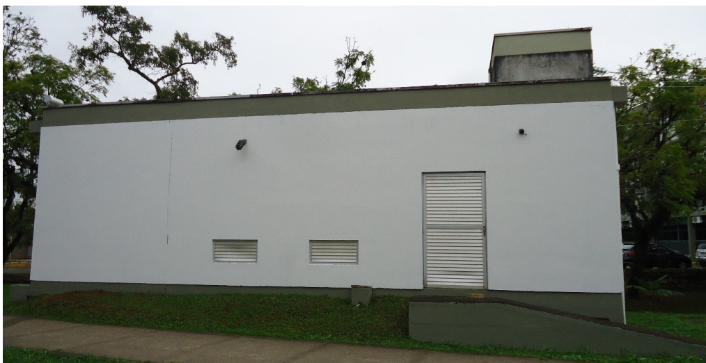
Figura 7 – Subestação de entrada – FLN.TRI – CMD01
