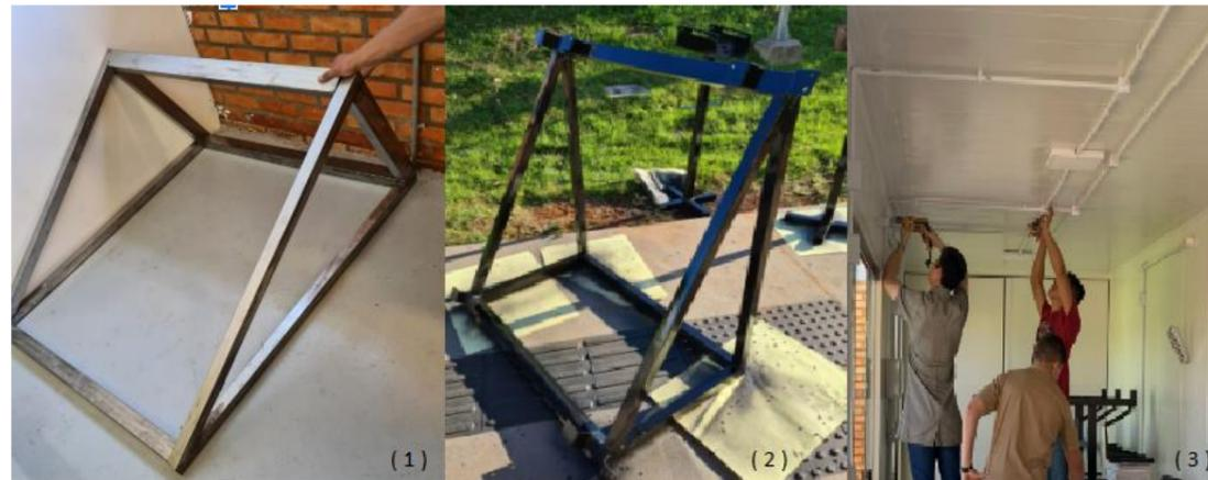
Figura 1: (1) - Estrutura de suporte dos painéis, (2) - Pintura da estrutura de suporte e (3) - instalação elétrica. Fonte: elaborado pelos autores.
