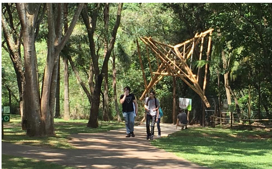
Figura 8: portal finalizado e instalado na entrada da trilha. Fonte: elaborado pelos autores.
