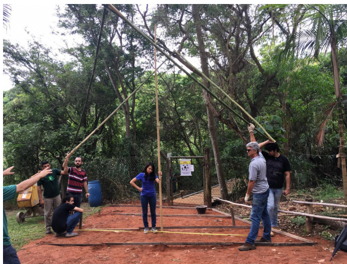
Figura 5: Visita técnica com simulação de posicionamento da estrutura do portal.
