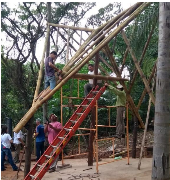
Figura 7: Montagem e fixação da estrutura do portal pela Viverde. Fonte: elaborado pelos autores.
