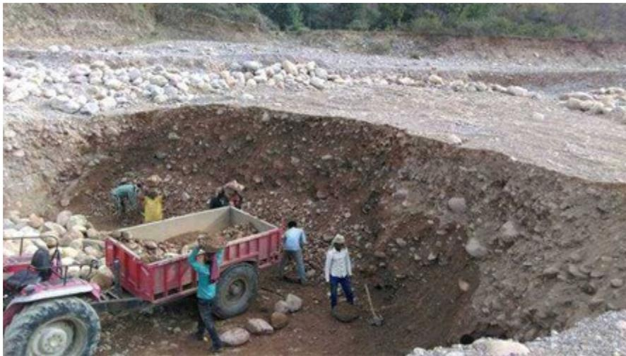
**Figura 4-14** Extracción de grava y arena en un lecho arenoso de 3 metros de profundidad. (SANPR, 2017).
