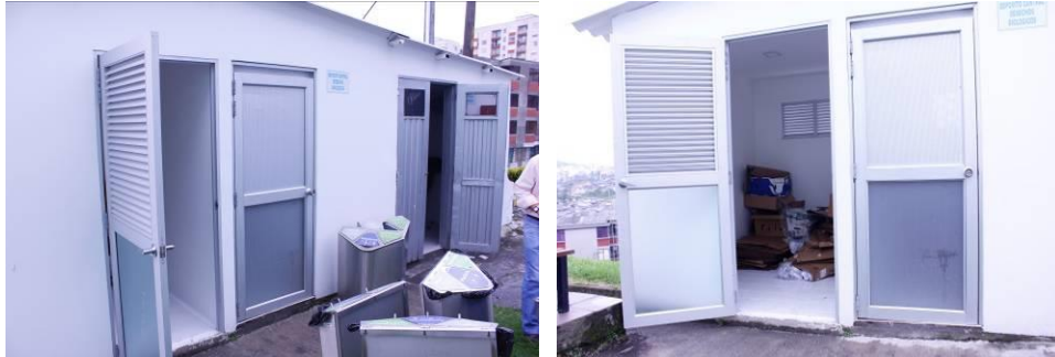
Imagen 10 y 11: Deposito de almacenamiento de residuos sólidos y cuarto de reciclaje
