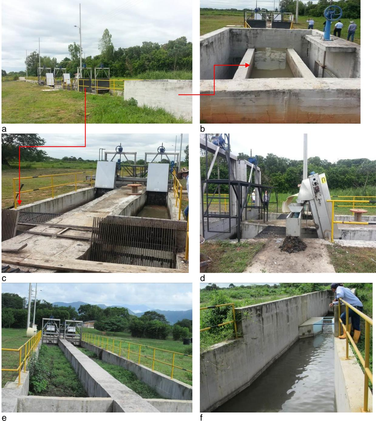
Figura 6. Secuencia del proceso. (a) Vista general del sistema de pretratamiento. (b) Punto de homogenización. (c) Rejillas de cribado. (d) Sistema de remoción de residuos sólidos. (e) Sedimentador. (f) Canaleta Parshall.
