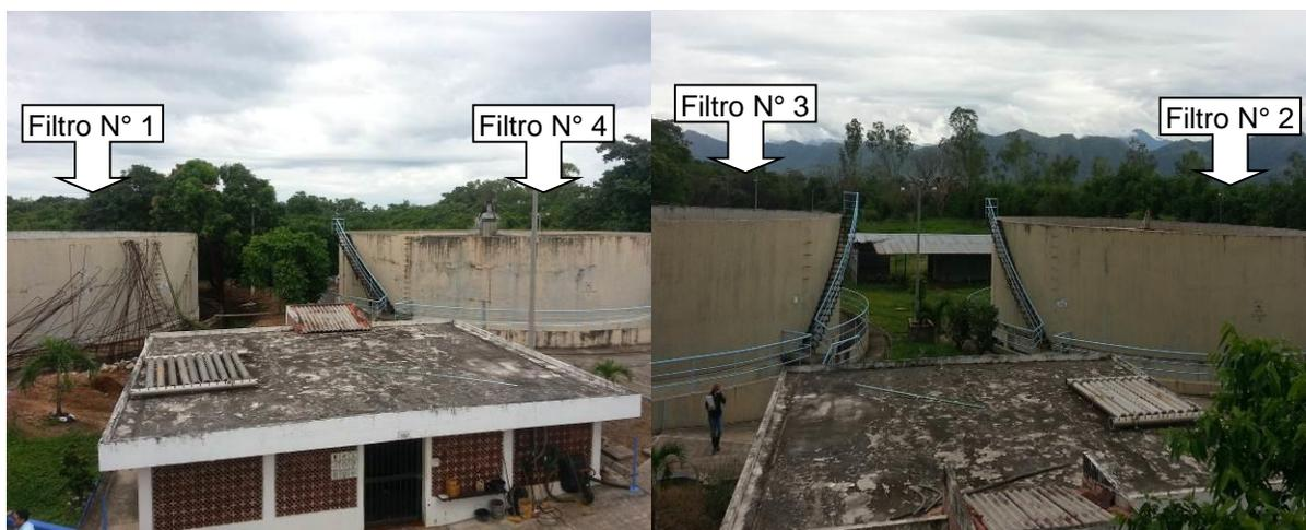
Figura 10. Cuarto de bombas sumergibles y filtros percoladores.
