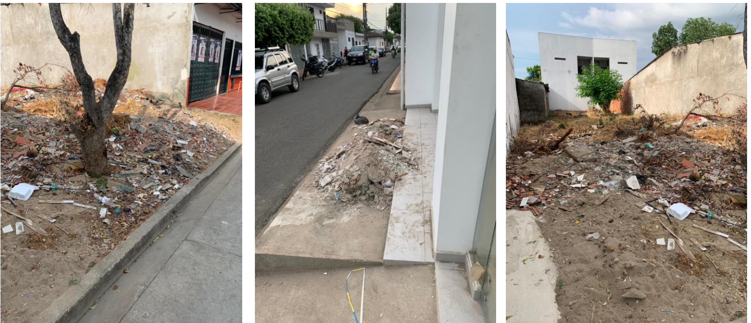
Ilustración 32: RCD depositados en lugares no autorizado en lotes para la cimentación de edificaciones unifamiliares.
