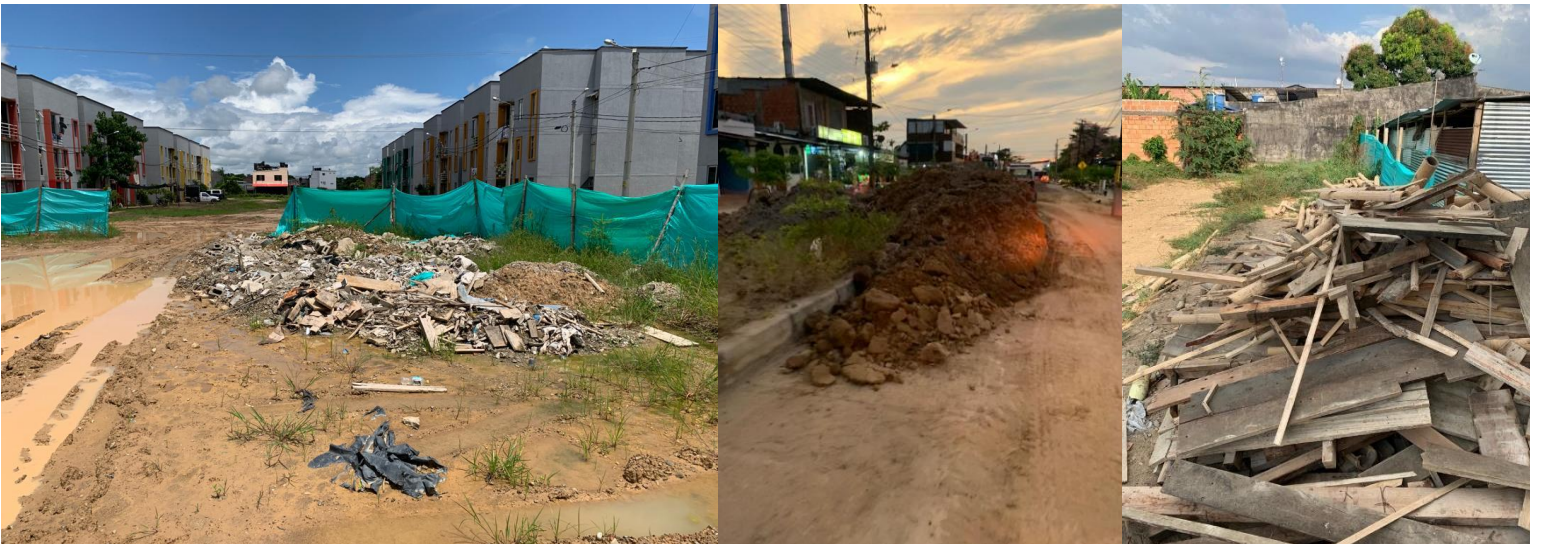
Ilustración 30: Almacenamiento temporal RCD en obra Fuente: Autor 2023
