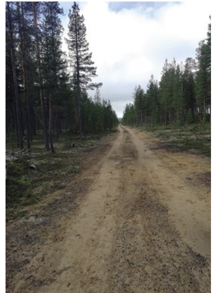
Oikein toteutetut metsätiet voivat vähentää haitallisia ympäristövaikutuksia ja suojella vesistöjä eroosiolta ja kiintoainekuormitukselta KUVA: LOTTA MÄKINEN
