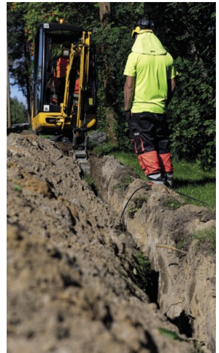
Vesistöissä tai vesistön lähellä toteutettavista pienimuotoisista hankkeista on tietyissä tapauksissa tehtävä ilmoitus ELY-keskukselle. Osa hankkeista voi vaatia vesilain mukaisen luvan. KUVA: KIMMO RAUATMAA
