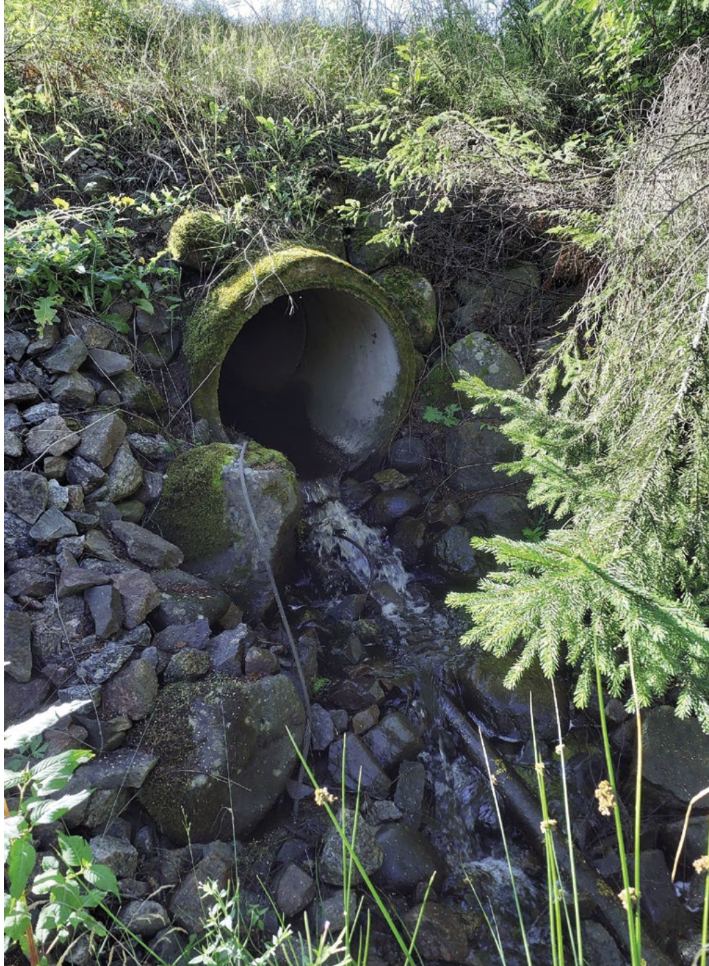
Vanhat padot tai tierummut voivat estää kaloja vaeltamisen kutupaikoilleen. KUVA: MIIA MÄKILOUKO
