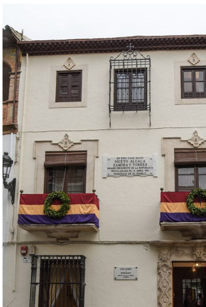
Imagen 1. Fachada de La Casa Natal y Museo de D. Niceto Alcalá-Zamora y Torres. Calle Río nº 33 de Priego de Córdoba, Córdoba, España
