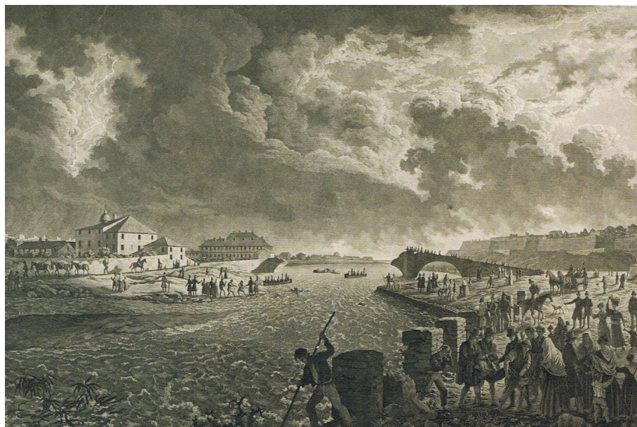
Figure 2. View of the Pila bridge over the Bisagno river near the walls of Genoa shortly after it was ruined by the great flood of October 26th, 1822, by Luigi Garibbo ( Veduta del ponte della Pila sul Bisagno presso alle mura di Genova poco dopo il suo diroccamento per la gran piena del 26 Ottobre del 1822 , Centro DocSAI, Collezione Topografica del Comune di Genova).
