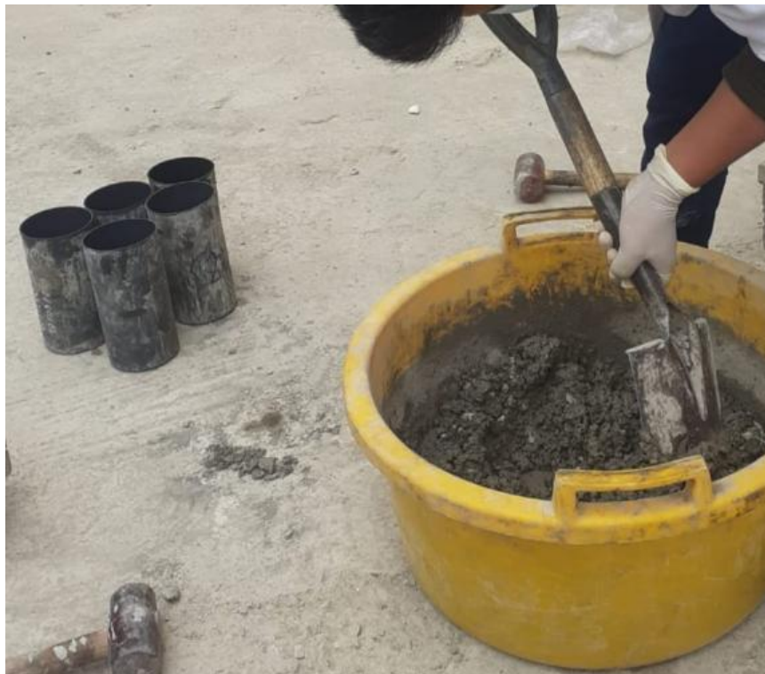
Imagen N°24.- Mezclado del concreto
