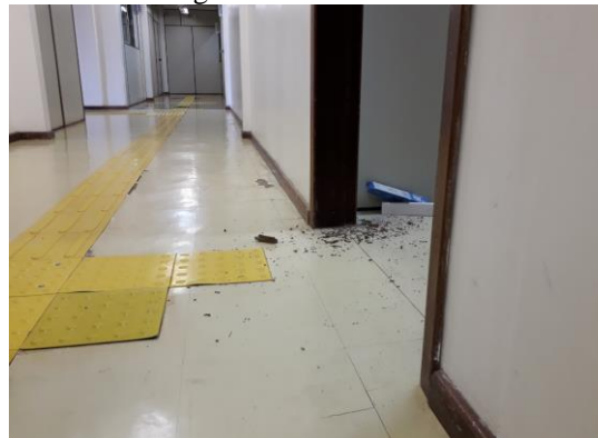
Figura 9: Manutenção Elétrica - Risco de Escorregões
