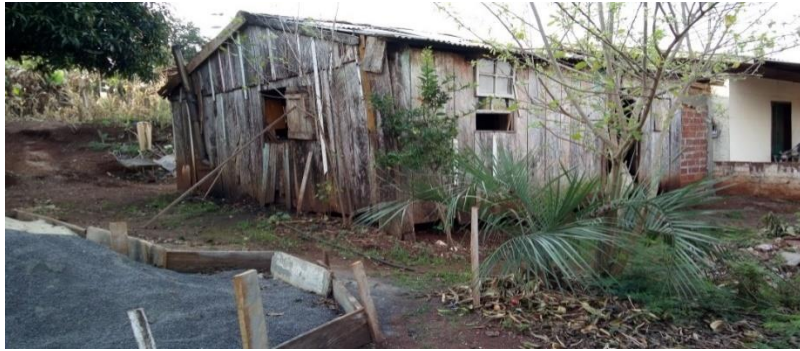
2ª. Imagem. Construção do banheiro/2017.
