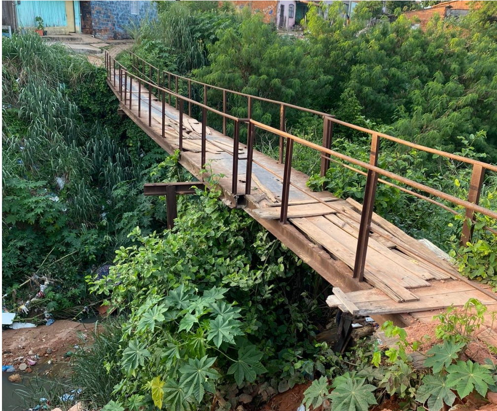
Figura 3 - Cobertura da Passarela
