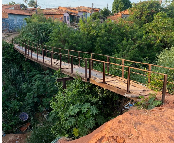
Figura 2 - Estrutura da Passarela
