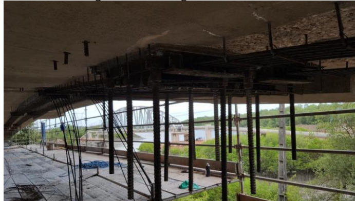
Imagem 2 - Ancoragem das cordoalhas
