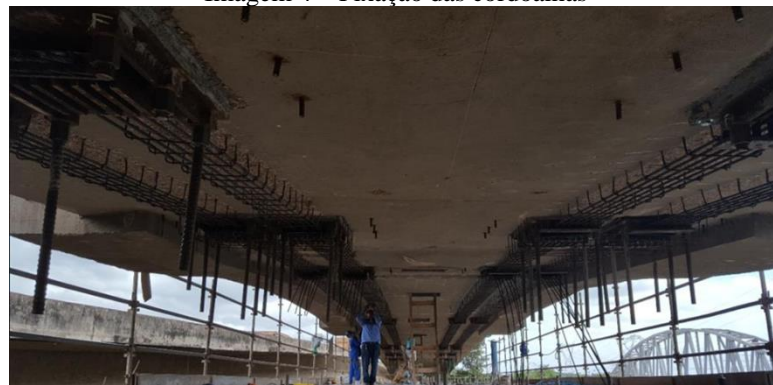
Imagem 4 – Fixação das cordoalhas
