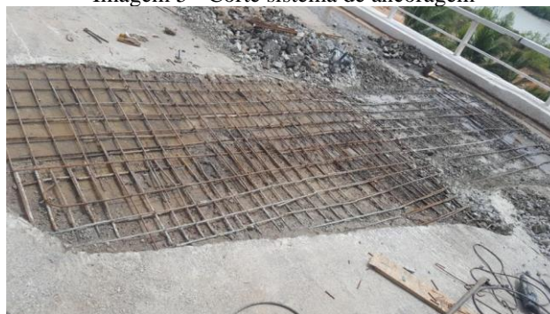
Imagem 5 - Corte sistema de ancoragem
