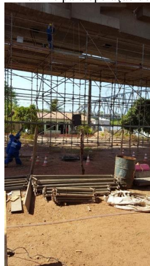
Imagem 1 - Andaime para operação dos trabalhos.
