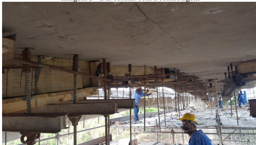
Imagem 3 - Das formas com a concretagem
