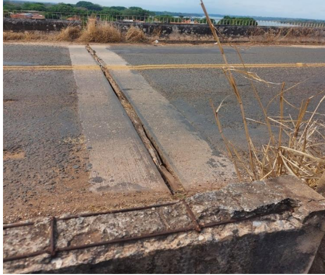
Imagem 7 - Juntas de dilatação na ponte Dom Affonso Felipe Gregory.
