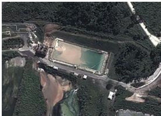
Figura 1 - Vista aérea da unidade
