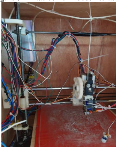
Figura 02 – Não conformidade nos cabos
