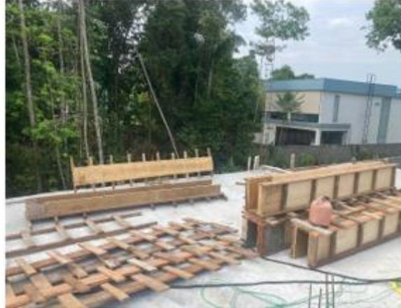
Após análise da estrutura, foi locado primeiramente os pilares de canto para posicionamento. Em seguida, definiram-se as vigas embaixo das paredes, e por fim, locaram-se os pilares de extremidade e intermediários. As demais instalações ocorreram conforme as etapas compostas no cronograma da obra. Outras etapas de execução dos serviços estruturais podem ser vistas nas figuras abaixo.
