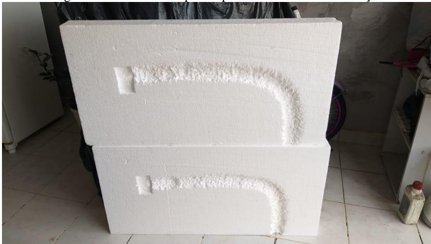
Figura 6 – Placa de EPS pronta para recebimento de tubulação
