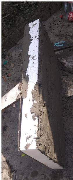
Figura 9 – Face do painel com reboco aplicado
