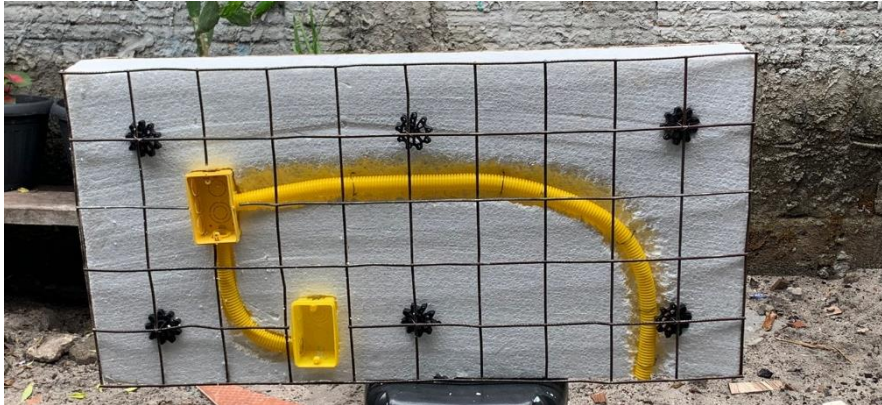
Figura 7 – Pannel com malha eletrosoldada e tubos de eletroduto
