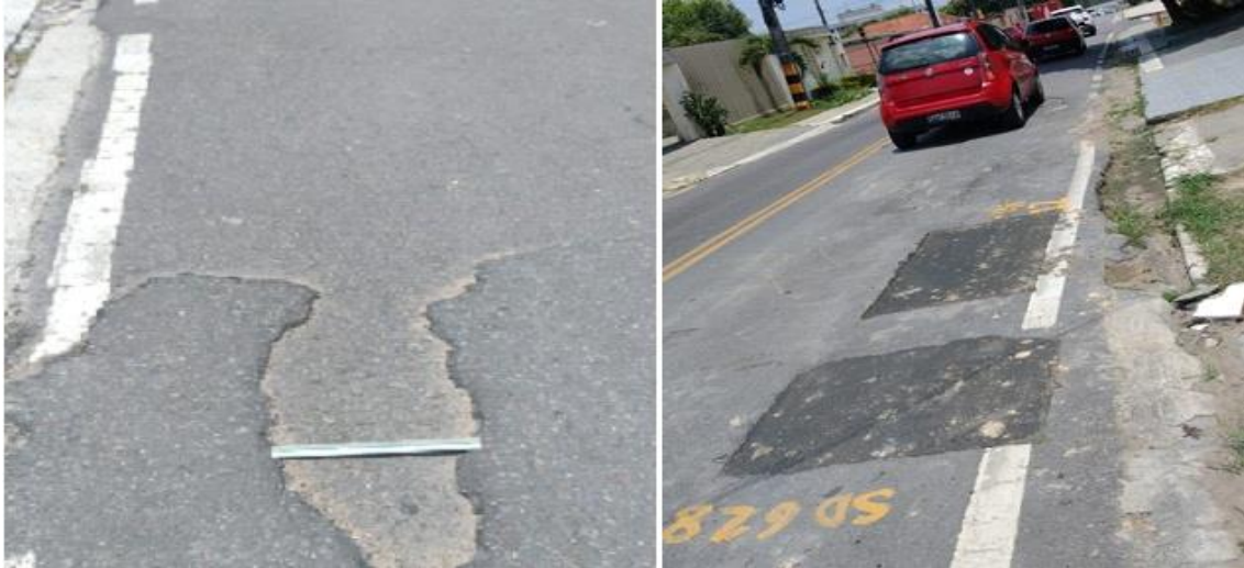
Figura 2: Desgaste e Remendo
