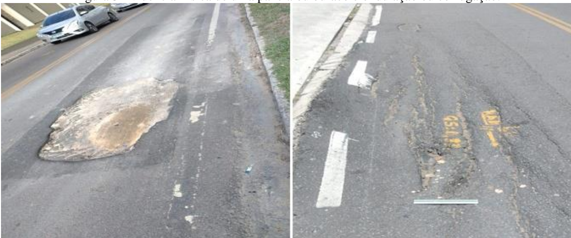
Figura 3 Evidencia Física de uma panela ou buraco e ondulação ou corrugação.
