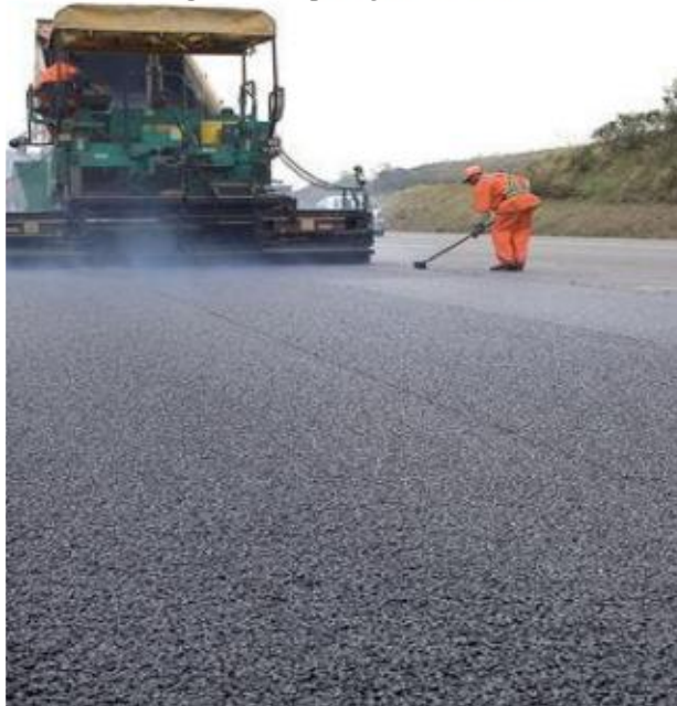
Figura 2 – Aplicação de CBUQ
