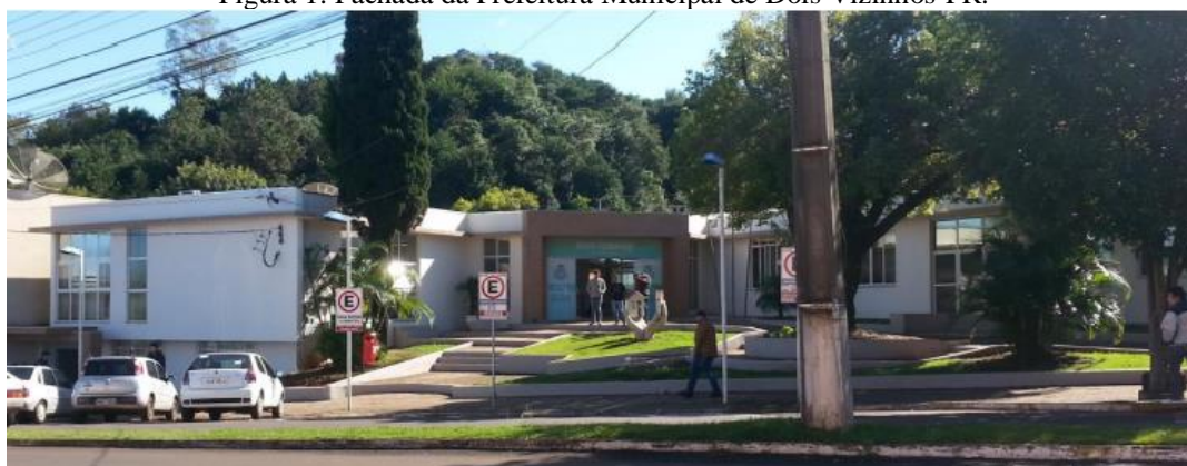
Figura 1: Fachada da Prefeitura Municipal de Dois Vizinhos-PR.
