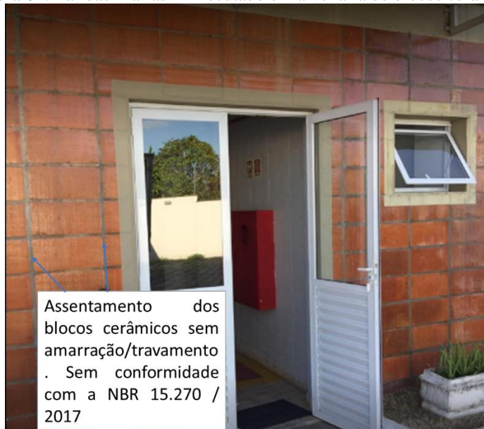
Figura 02: Lar das Marias – Executado em alvenaria de blocos cerâmicos
