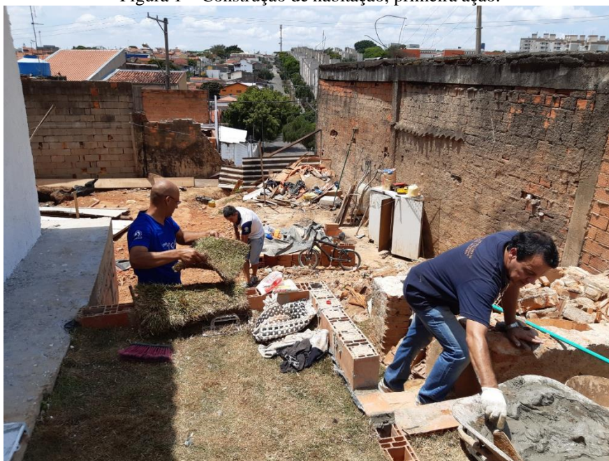
Figura 1 – Construção de habitação, primeira ação.
