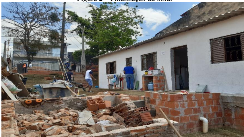
Figura 2 – Finalização da obra.
