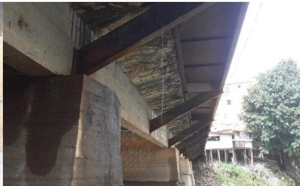
Na figura 11 foi detectado um mau funcionamento do órgão de drenagem acarretando umidade ao redor e conseqüentemente a desagregação do concreto e facilitando a corrosão. Observa-se na figura 12 uma degradação na estrutura ocasionado pela oxidação.
