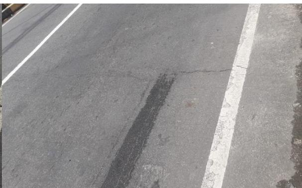
As figuras 7 e 8 pode-se verificar que a pista de rolamento mostra seu desgaste e ineficácia na estrutura onde apresenta muitas fissuras com aberturas ao longo de toda sua extensão, provenientes da falta de manutenção
