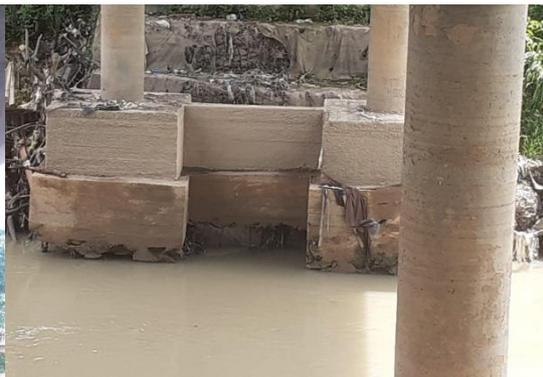
Na figura 5 observa-se uma patologia, que consiste na exposição e corrosão das armaduras da viga principal da Ponte, em decorrência do cobrimento inadequado, o qual não promoveu a proteção das armaduras. Na figura 6, pode-se observar uma patologia, que consiste em um desgaste superficial no pilar da ponte, ou seja, uma perda de massa ocasionada pelo processo de abrasão, devido ao atrito de galhos de árvores e outros materiais que acompanham o curso do rio.
