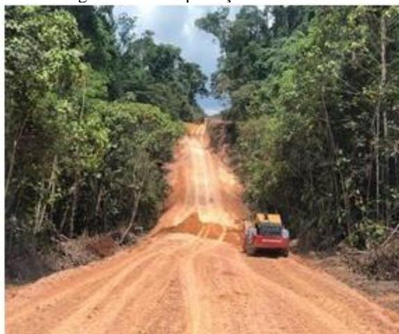
Foi passado oito vezes de cada lado o rolo vibratório da borda da estrada para seu centro. Com a camada de 30 cm, compactadas. Foi realizado o ensaio de grau de compactação, constatou-se 85% Proctor Normal, com desvio de umidade de +/- 2%. Sendo necessário realizar mais quatro passadas de em cada lado com o rolo vibratório.
