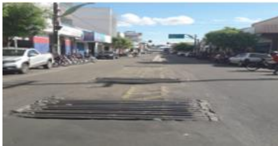
Figura 7 – Bocas de Lobo a céu aberto na rua Tristão Gonçalves.
