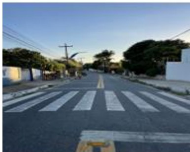
Figura 3 – Falta de acostamento na avenida José Horácio Pequeno
