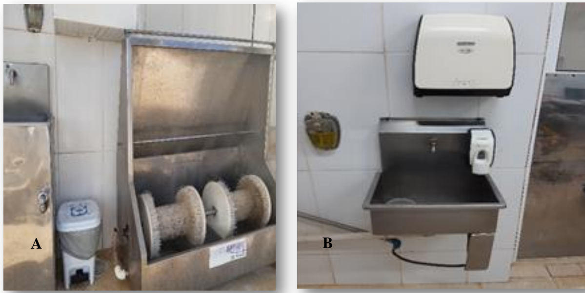
Figura 3 - Barreira sanitária de acesso a entrada com lava botas (A) e pia (B) para assepsia de mãos em uma agroindústria de embutidos cárneos em Pelotas/RS, 2019/21.
