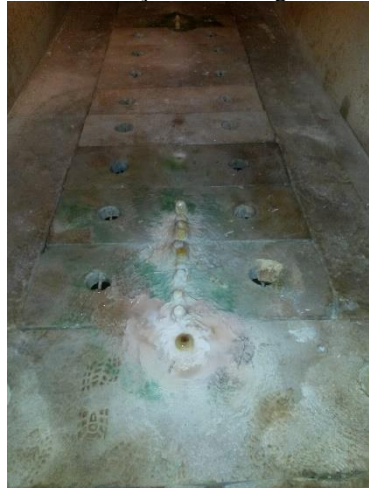
Figura 4 - Formação de estalagmites – UHE-Tucuruí
