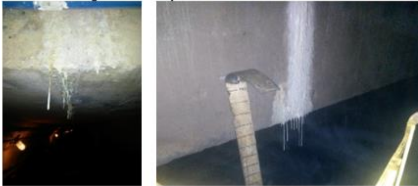
Figura 3 - Formação de estalactite – UHE-Tucuruí
