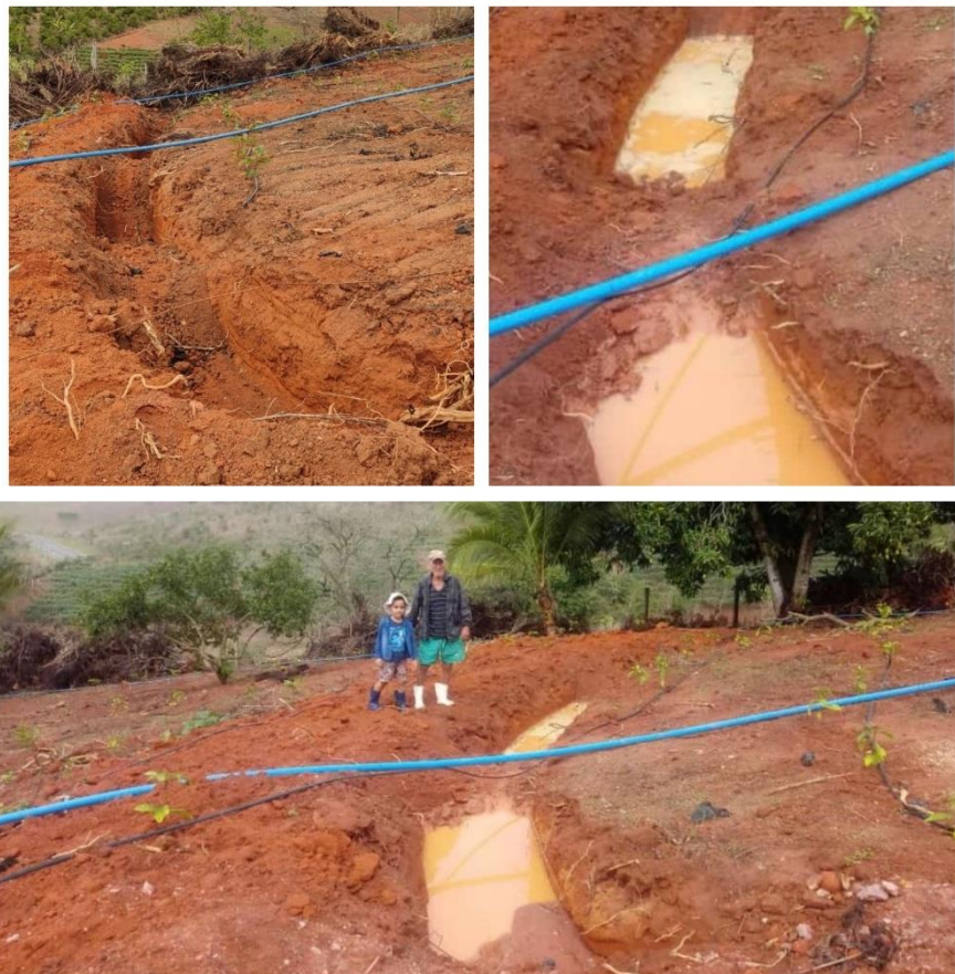
Figura 8 - Captação e infiltração de água da chuva nos cochinhos em curva de nível na zona rural do município de Atílio Vivácqua, Espírito Santo, Brasil.
