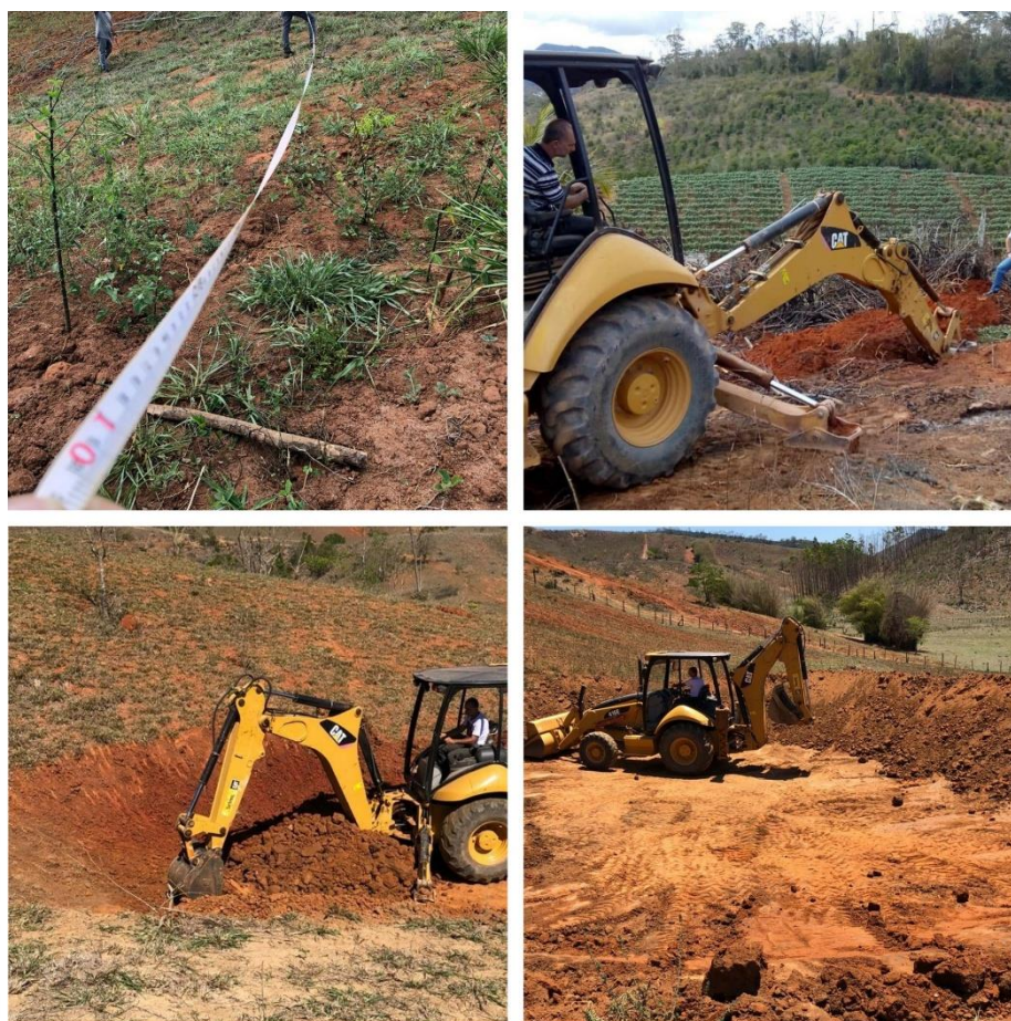
Figura 4 - Construção dos cochinhos e barraginhas planejadas para zona rural do município de Atílio Vivácqua, Espírito Santo, Brasil.
