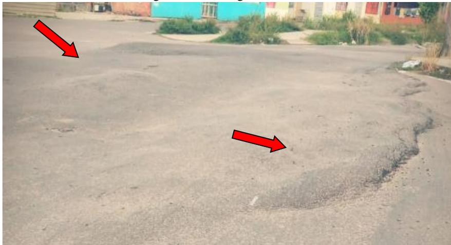
Para o tratamento da patologia de afundamento são sugeridas duas opções de técnicas, a saber: a fresagem e o recapeamento. O recapeamento trata-se da construção de uma ou mais camadas asfálticas sobre o pavimento já existente, a fresagem é o processo de corte do revestimento asfáltico existente para a restauração da superfície de rolamento.
