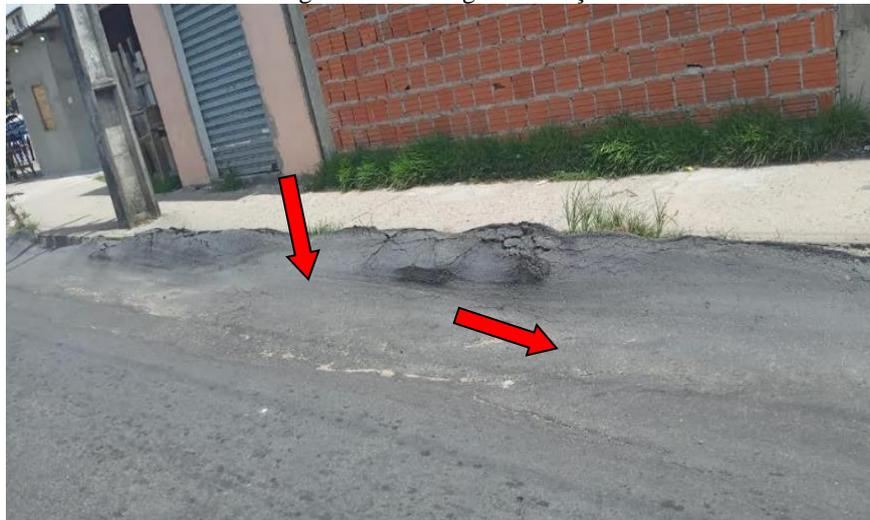
Como pode-se observar na Figura 8 a patologia de ondulação é resultante da má distribuição do ligante em camadas de concreto betuminoso, fazendo com que ocorra o arrastamento da mistura. Uma sugestão de reparo dessa patologia é o recapeamento estrutural de uma ou mais camadas asfálticas sobre o pavimento existente.
