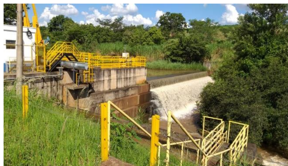
Chibarro: Barragem. Foto 2: Denilson Bertolaia – 14/02/2020.
