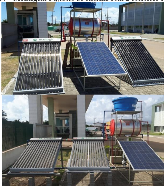
Figura 14 – Montagem e ajustes do sistema com 2 coletores evacuados
