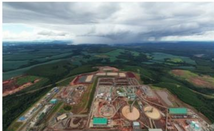
Figure 3- Project Puma II– Rio De Janeiro.
