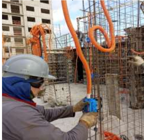
Imagem 4 - Instalação do kit elétrico industrializado para o sistema de parede de concreto – ESTRUTURA.
