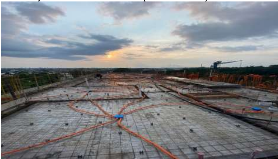
Imagem 5 - Instalação do kit elétrico industrializado para o sistema de laje de concreto – ESTRUTURA
