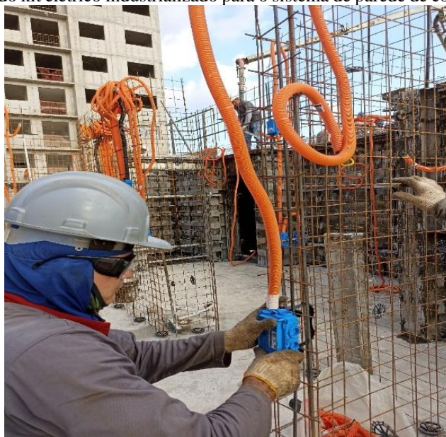
Imagem 4 - Instalação do kit elétrico industrializado para o sistema de parede de concreto – ESTRUTURA.
