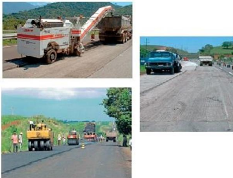
Figura 8: Fresagem em rodovias.
