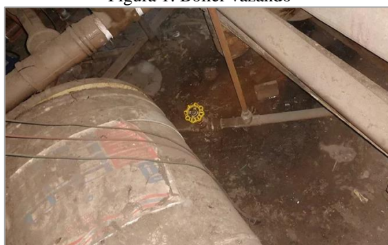
Figura 1: Boiler vazando
