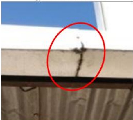
Figura 15: Solda danificada
