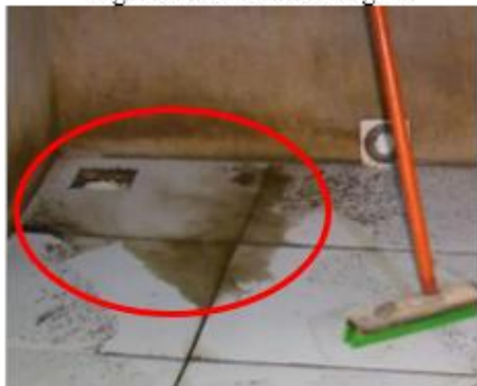
Figura 23: Retorno de esgoto
