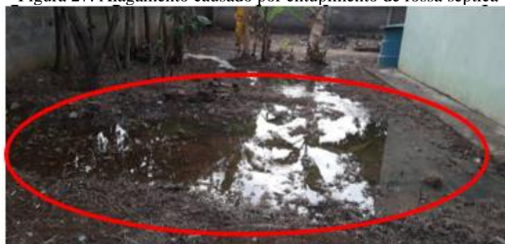
Figura 27: Alagamento causado por entupimento de fossa séptica
